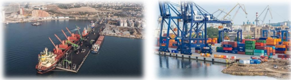
Şekil 3.17. Kuru yük ve konteyner terminali.
