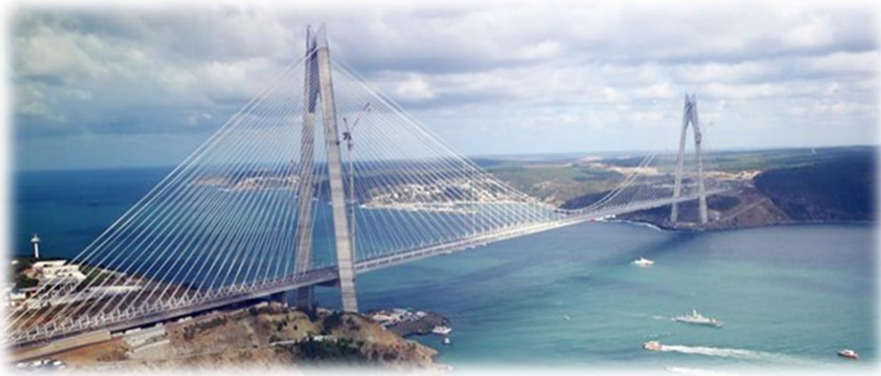
Şekil 3.3. Yavuz Sultan Selim Köprüsü.
