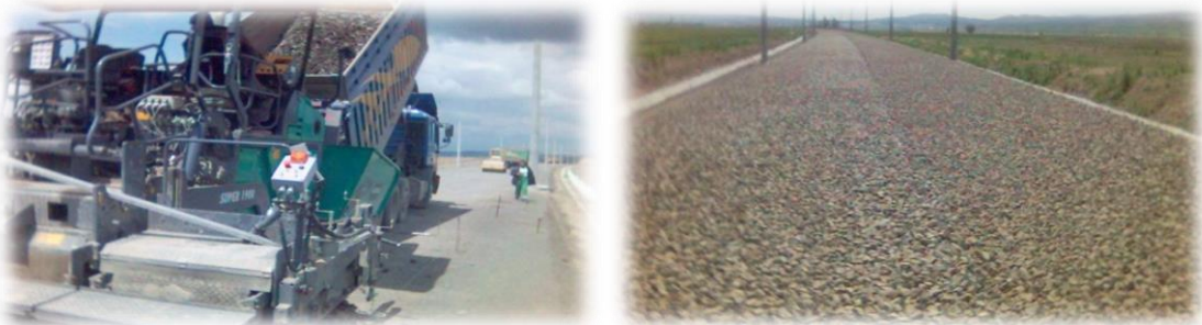
Şekil 3.10. Platform ve üzerine balast serimi.
