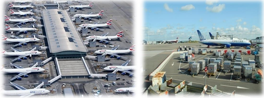
Şekil 3.23. Yolcu ve kargo terminali apron görünümü.
