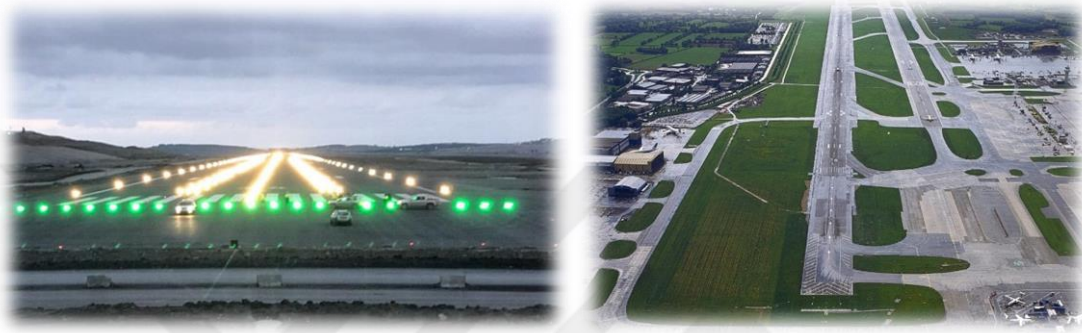
Şekil 3.22. Gece ve gündüz havaalanı pist görünüşü.
