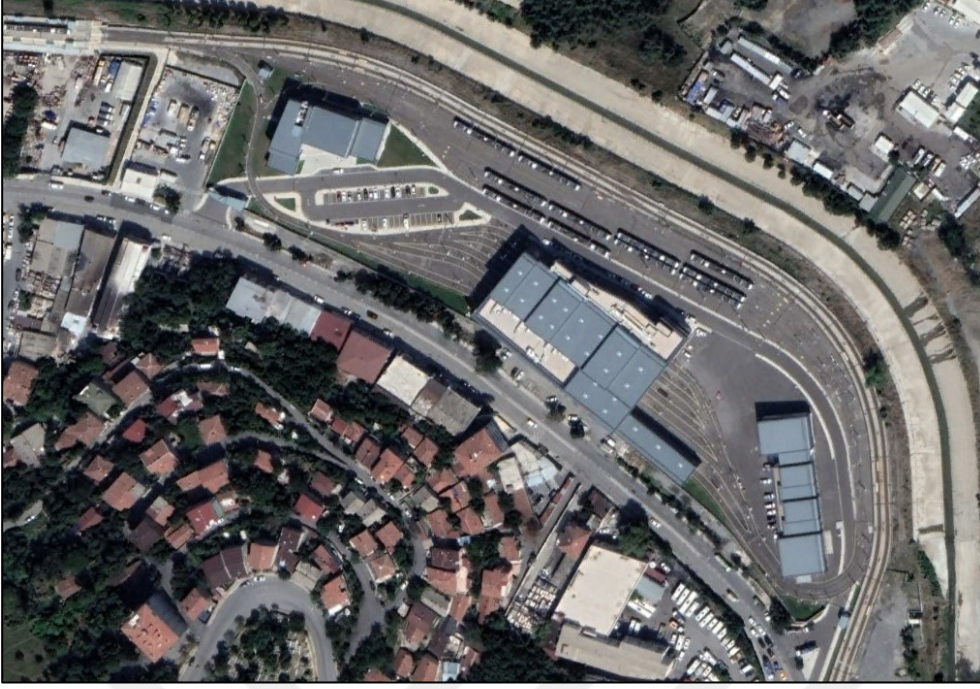
Şekil 3.3. Tramvay hattının depo sahası ve bakım atölyelerine ait uydu görüntüsü [13].
