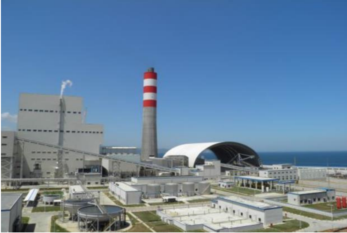
Şekil 3.13 İçdaş Bekirli Termik Santrali.
