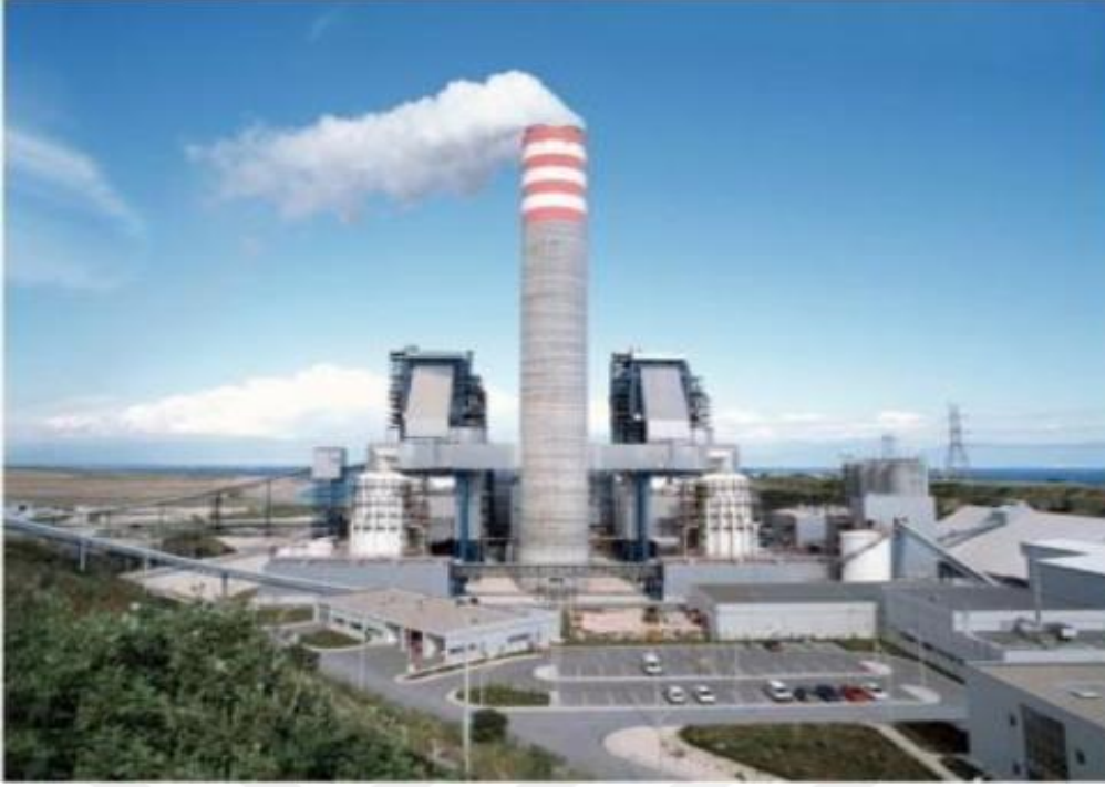
Şekil 3.9 İskenderun Sugözü Termik Santrali.
