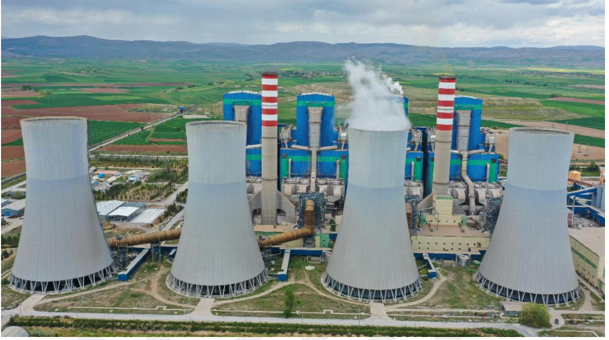
Şekil 3.4 Afşin-Elbistan B Termik Santrali.
