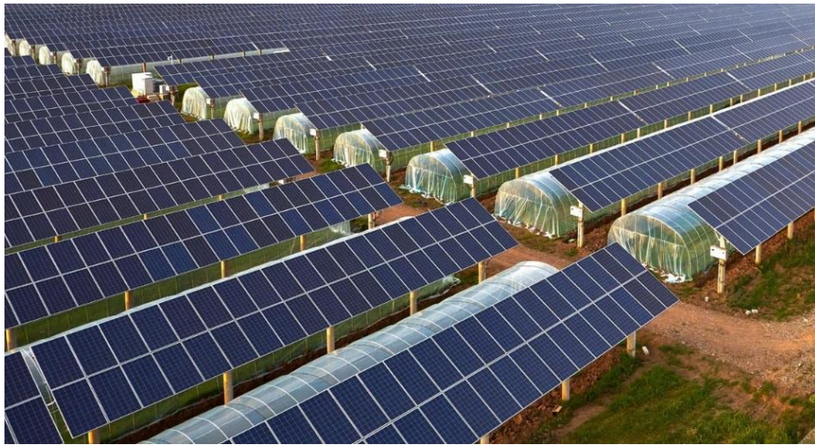
Görsel 2.6. Plastik örtü ile kurulmuş sera yanına kurulan fotovoltaik panel görüntüsü (Özdemir, 2022)
