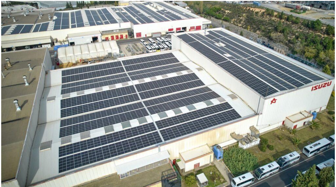
Görsel 2.4. Anadolu Isuzu tesislerinin çatı fotovoltaik sistem görüntüsü (Taşıyanlar, 2022)
