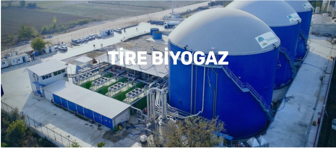
Görsel 3.1. Tire Biyogaz Tesisinden Bir Görüntü (http-6).
