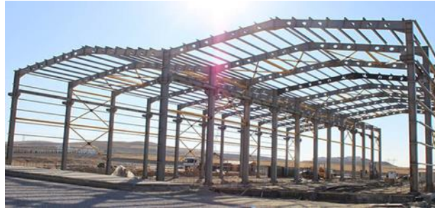
Resim 2.17. Çelik konstrüksiyon yapı
