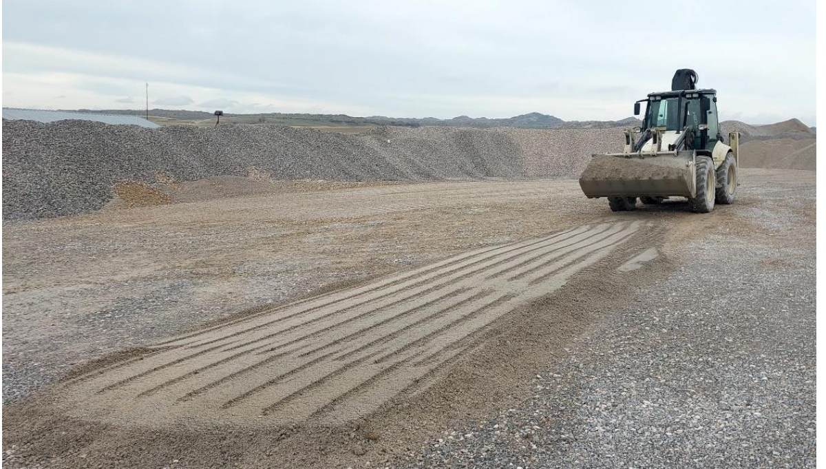
Şekil 3.15: Geri Dolgu Malzemesi Alt Tabaka Serim İşlemi.
