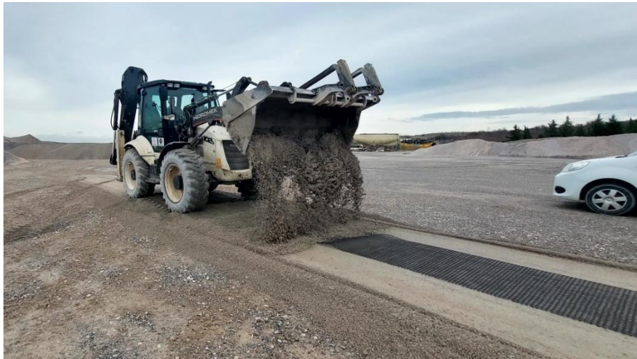
Şekil 3.18: Geogrid Üzerine Serilen Geri Dolgu Malzemesi Üst Tabaka İşlemi.
