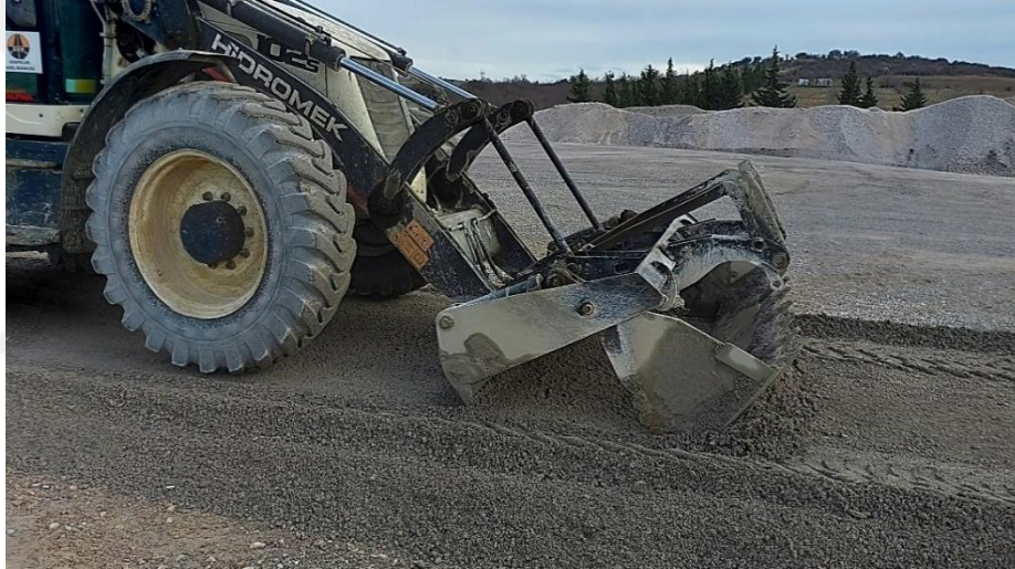
Şekil 3.20: Sıkıştırılan Tabakaların Sökülme İşlemi.
