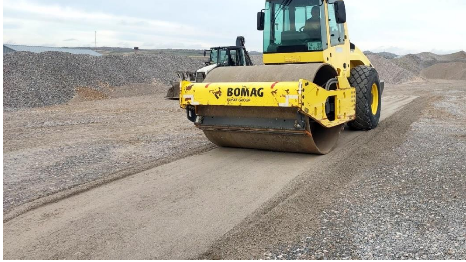
Şekil 3.16: Geri Dolgu Malzemesi Alt Tabaka Sıkıştırma İşlemi.
