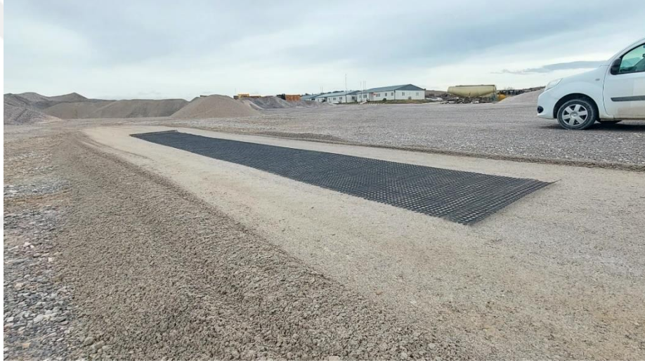
Şekil 3.17: Tabakalar Arasına Geogridin Serilme İşlemi
