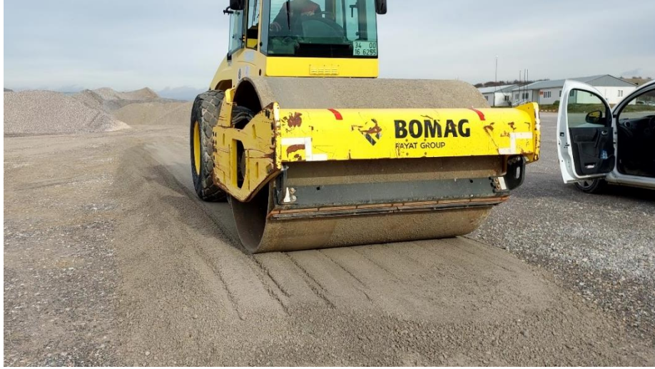
Şekil 3.19: Geri Dolgu Malzemesi Üst Tabakasının Sıkıştırılma İşlemi.
