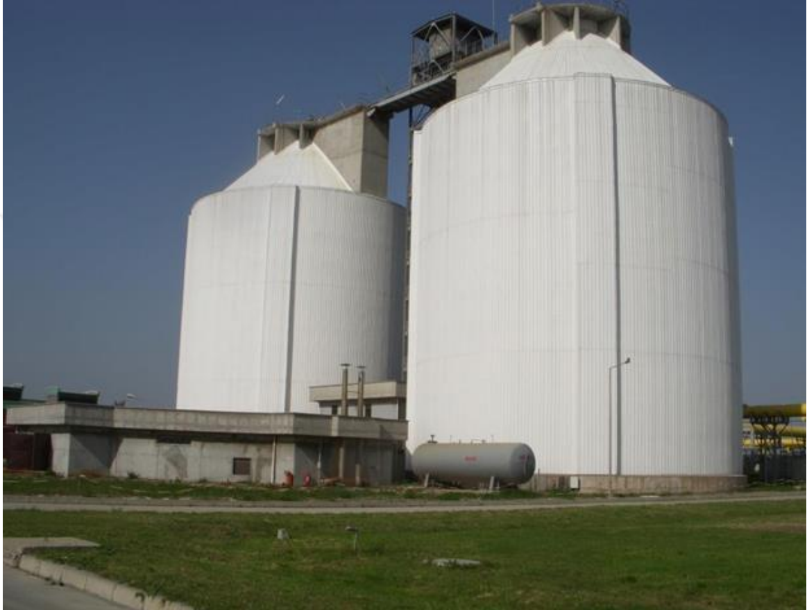
Şekil 1.1. Çalışmaya konu olan arıtma çamurunun temin edildiği Yüreğir Atıksu Arıtma Tesisi'nde bulunan anaerobik çürütme üniteleri (Adana Su ve Kanalizasyon İdaresi)
