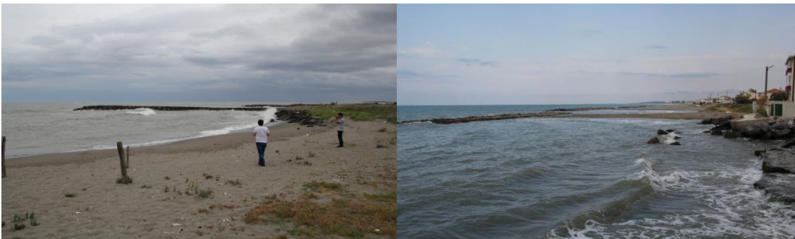
Şekil 12 Kızılırmak Deltasına yerleştirilen dikey ve yatay mahmuzlar (dalga kıranlar)
