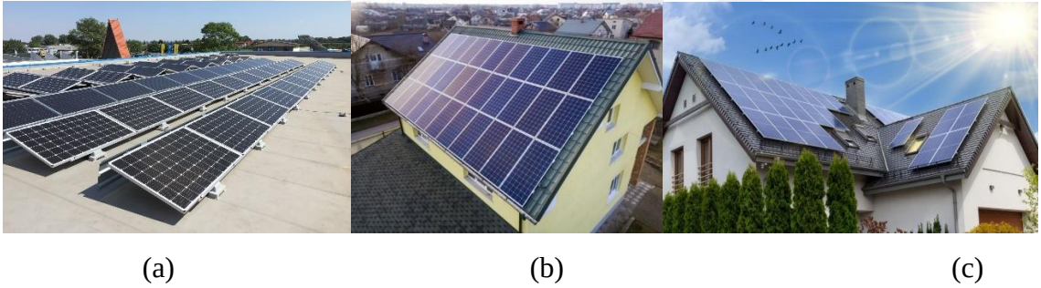
Şekil 6.1. (a) Düz çatıya kurulmuş sistem (b) Bir eğimli çatıya kurulmuş sistem (c) Birden fazla eğime sahip çatıya kurulmuş sistem
