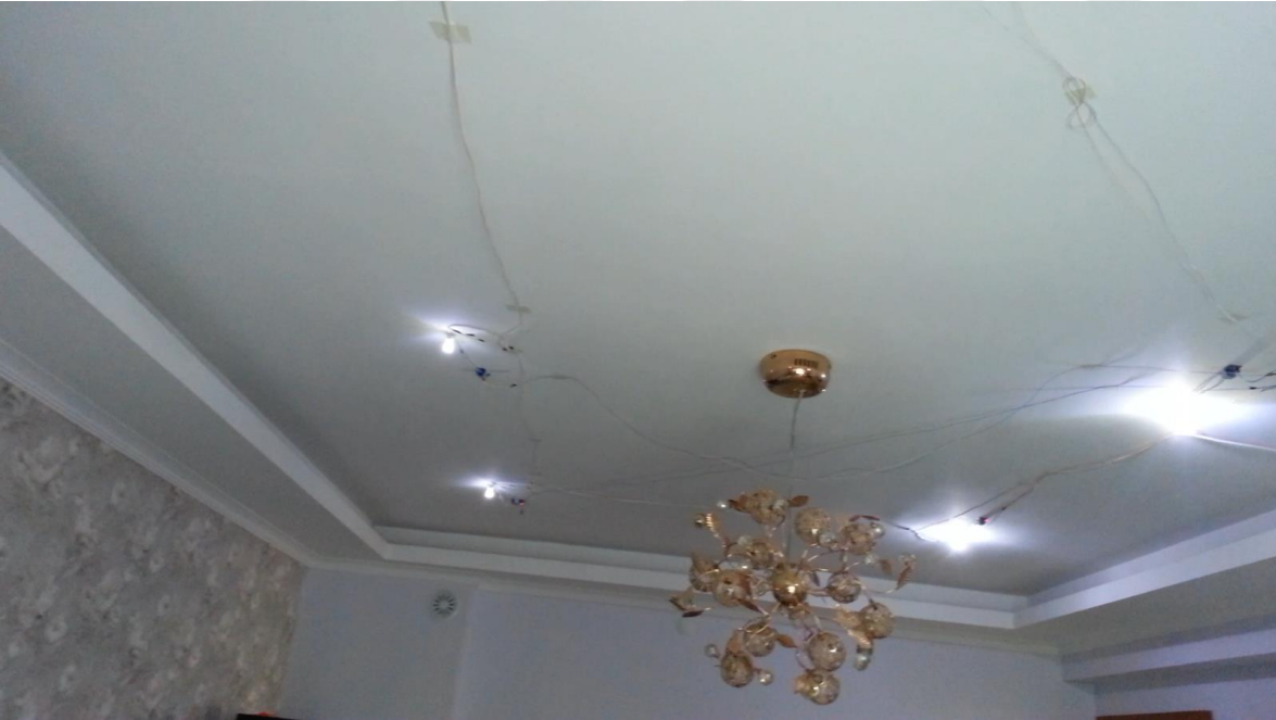
Şekil 4. 20. Salonun ışığı yetersiz olduğunda ledler çalışmaktadır.
