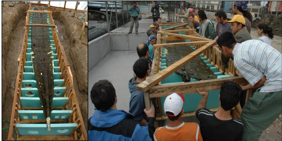
Şekil 24: Kalıplar iskelete bağlandıktan sonra kütle halinde kaldırma
