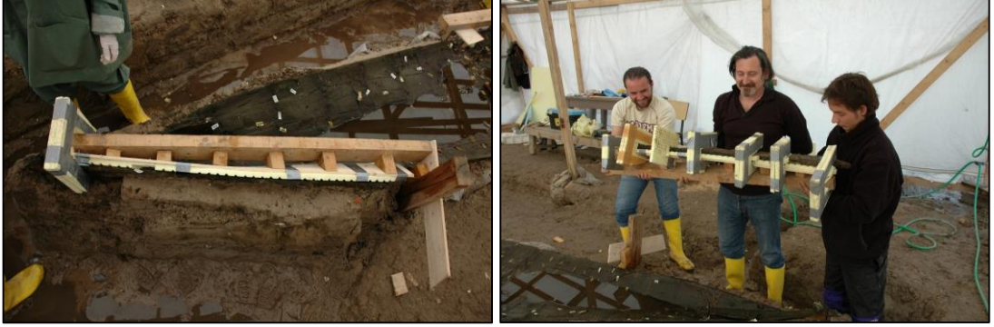
Şekil 22: Arazide demonte çalışmaları
