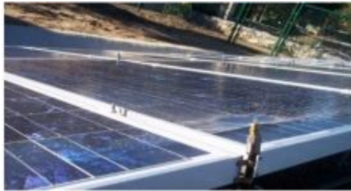
(e) Helioteks Temizleme Sistemi (HCS) (Abdolzadeh ve Ameri, 2009).
