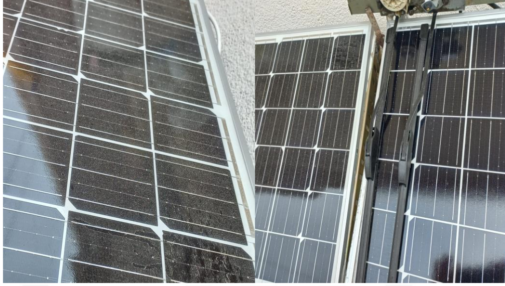
Şekil 3.23. Tozlanan panel ve düzenli temizlenen panelin görünümü.
