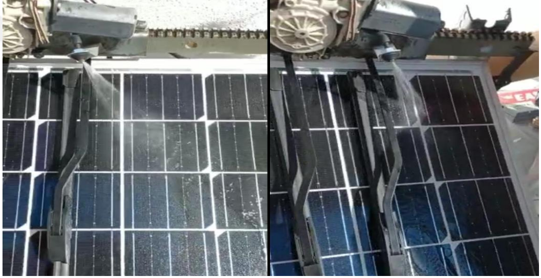
Şekil 3.22. Sulu temizleme yapılan panelin temizlenmiş hali.
