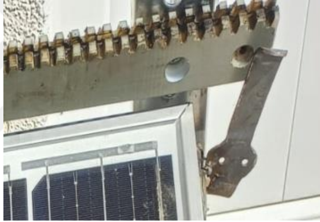
Şekil 3.12. Sınırlayıcının metal ayaklara yerleştirilmesi.
