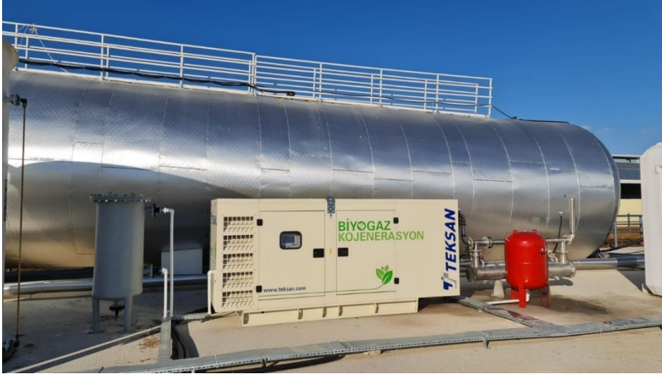
Şekil 3.10 Biyogaz tesisi saha kurulumu.
