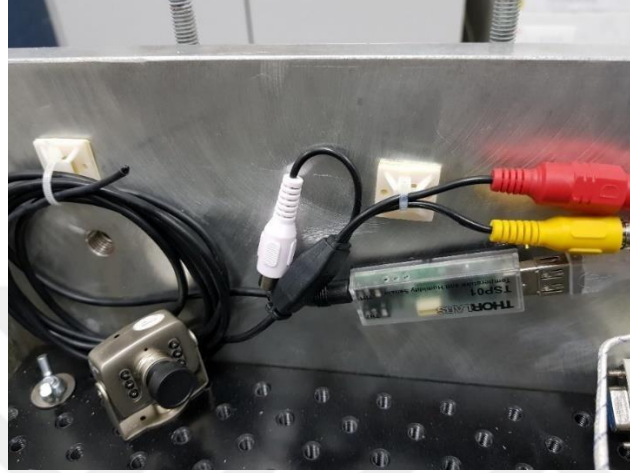
Şekil 3.15. Nem ve sıcaklık kontrolü montajı.
