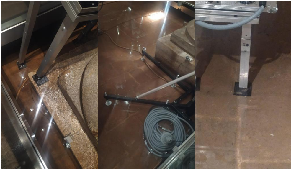
Şekil 6. 12: Sarnıç zemininde sehpa ve truss ayakları (Şerefiye Sarnıcı İşletme Şefinin Arşivinden, 2023)
