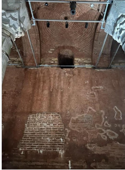
Şekil 6. 2: Şerefiye Sarnıcına ait duvar ve tavan yüzeyi
