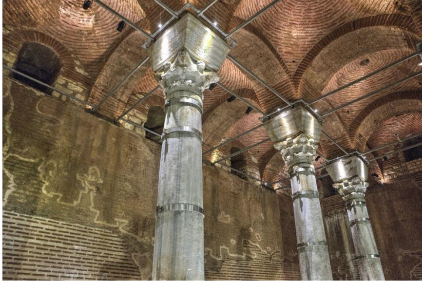
Şekil 6.1: Şerefiye Sarnıcı beden duvarı ve üst yapı, İstanbul, Türkiye, 2023 (Wikipedia, 2023)
