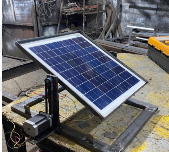
Şekil 5. 11.Taşıyıcı sistem imalatı.
