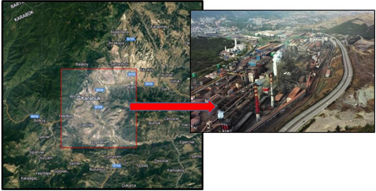
Şekil 4.15 Karabük Demir Çelik Fabrikası ve çevresi çalışma alanı.
