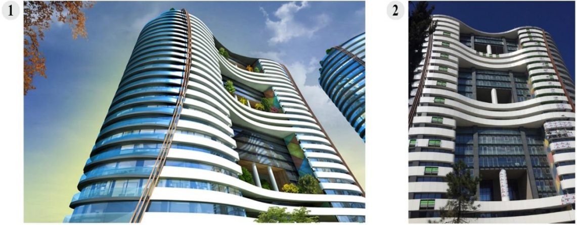
Şekil 25. Kentplus projesi, kat bahçelerinin cephedeki görünümü; 1. 3 boyutlu görsel (URL-18, 2022), 2. Cephe fotoğrafı (URL-19, 2022)
