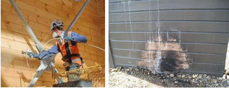
Şekil 19. Ahşap yüzeye yangın geciktirici kaplama uygulaması (URL-28, 2021)
