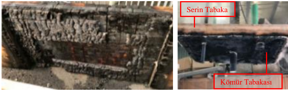
Şekil 16. Carbon12 yapısının yangın testi sonucu CLT paneldeki kömür tabakası (URL-24, 2023)
