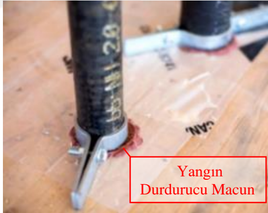
Şekil 20. Origine yapısında yangın durdurucu macun uygulaması (URL-32,2023)
