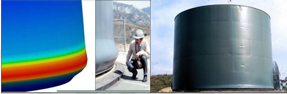
Resim 2.1: Fil ayağı burkulması(https://blog.cartif.com), (Malhotra ve diğ. 2000), (DiCarliccio ve diğ. 2008)
