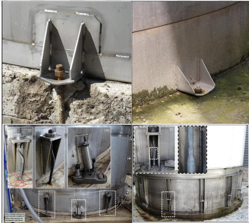
Resim 2.6: Tankta ankraj bulonunun betondan ayrılması, ankraj plakasının eğilmesi, ankrajın kopması (Brunesi ve diğ. 2015), (Dizhur ve diğ. 2017).
