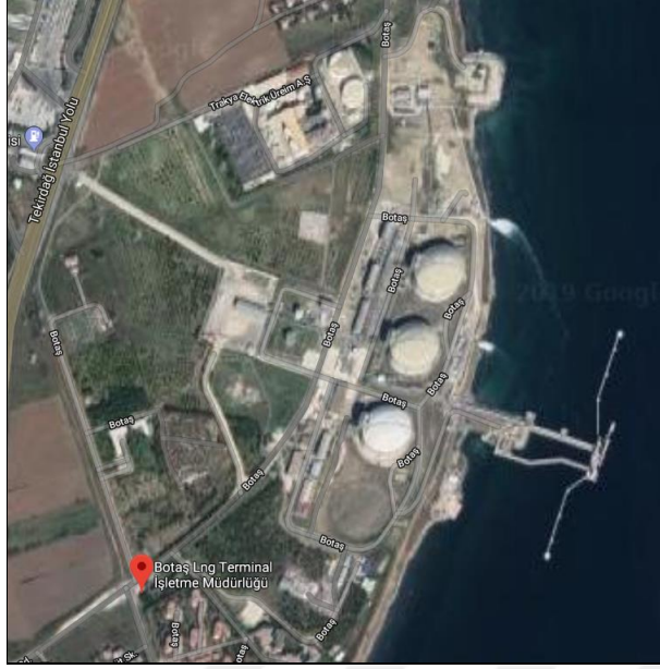
Resim 4.1: Marmara Ereğlisi BOTAŞ Tesisi LNG Tankları
