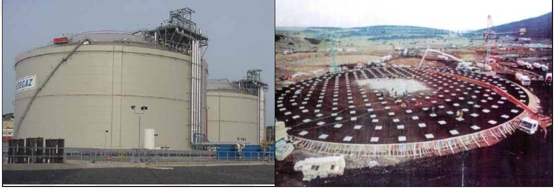
Resim 2.11: İzmir Aliğa Egegaz 140,000 m 3 hacimli LNG Tankları Her biri için 112 LRB 241 HDRB kullanılmıştır. D:85 m H:35 m (www.terbayinsaat.com).
