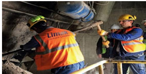
Şekil 1.8 Siklon şişleme işlemi.
