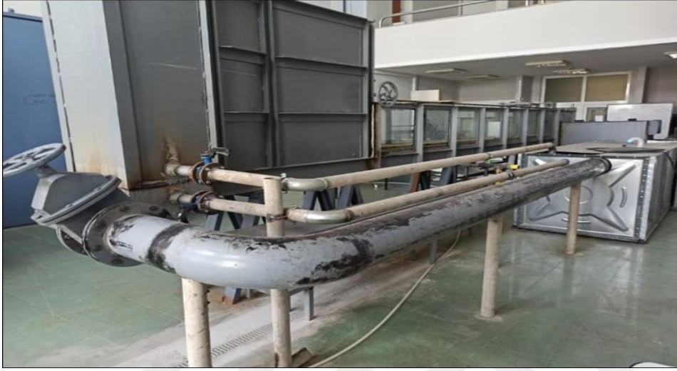
Şekil 2.1. Deneysel çalışma için kullanılan açık kanal sisteminin genel görünümü.
