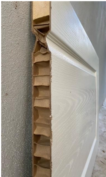
Şekil 9: Ahşap panel kapı iç görüntüsü
