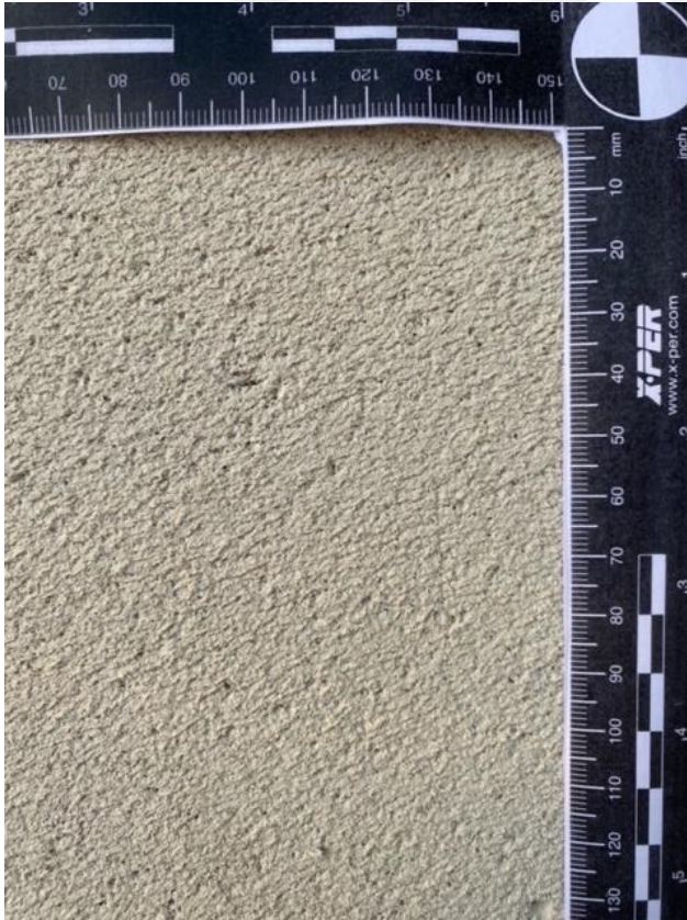
Şekil 5: Ölçekli, gözenekli yapısı gaz beton
