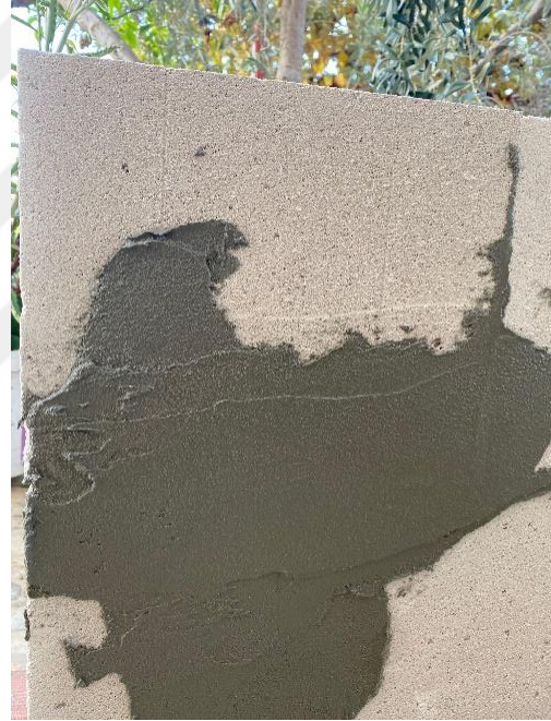
Şekil 8: Gaz betonda sıva yapılırken
