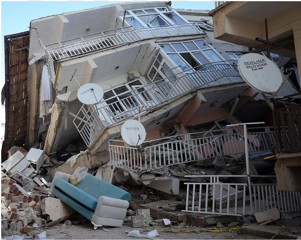
Şekil 3.7. Kolon alt bölgesinde meydana gelen plastik mafsallaşma durumu (2020 Elâzığ depremi) (ANADOLU AJANSI, 2022)
