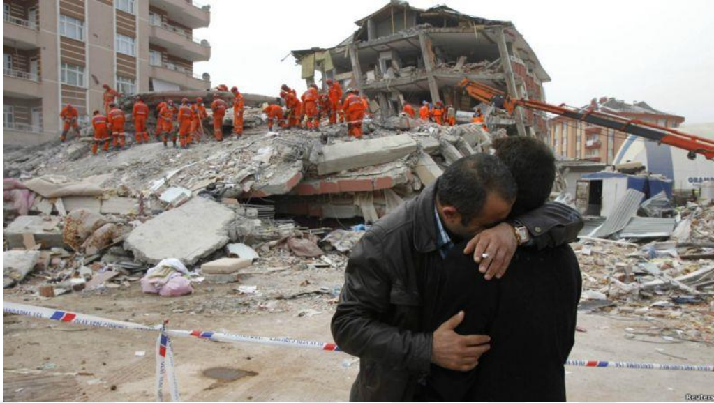
Şekil 3.6. Katları üstü üste çökmüş bir bina (2011 Van depremi) (AFAD, 2022)
