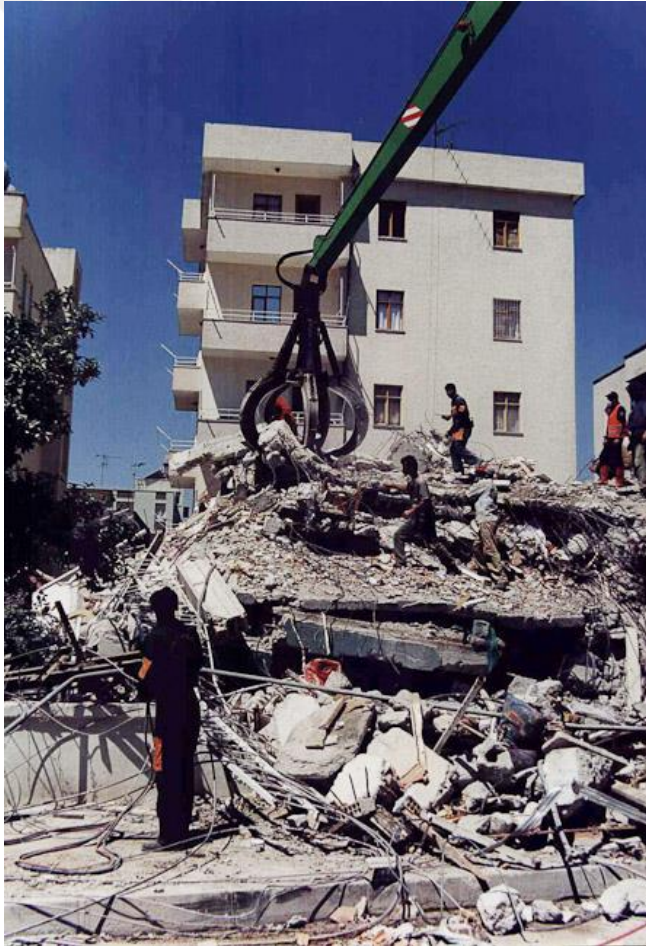
Şekil 3.3. Kolon - kiriş birleşim bölgesi hasarı sonucu yıkılmış bina (1998 Adana Depremi) (AFAD, 2022)
