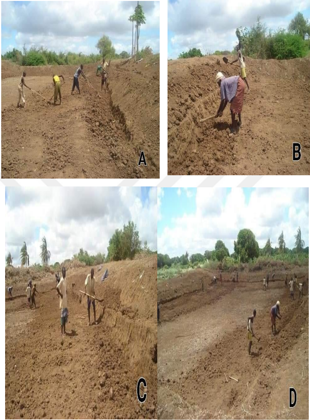
Şekil 3.2. Su hasadı için hazırlanan kum barajına ilişkin görüntüler. Kerlinger (2003), anket yöntemiyle katılımcılardan veri toplamak için yaygın olarak kullanılan ve orada neler olup bittiğini veya var olduğunu bilmek isteyen araştırmacılar tarafından kullanılan etkili bir araç olduğunu belirtmiştir. Uygulanan anket dört bölümden oluşmaktadır. İlk bölüm yanıtlayanlarla ilgili, diğer üç bölüm ise araştırmayla ilgili bir dizi soruyu içermektedir.
