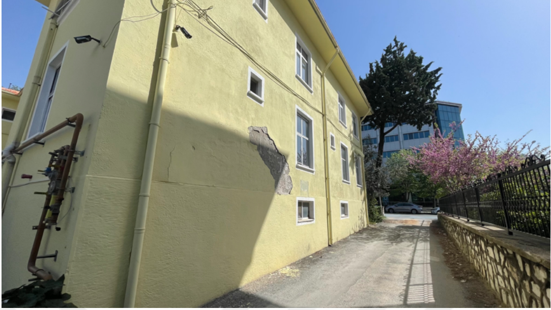
Şekil 5.20 Dış cephede yıpranmalar ve uygunsuz donatı ekleri (Giresun Erdoğan arşivi, 2022)
