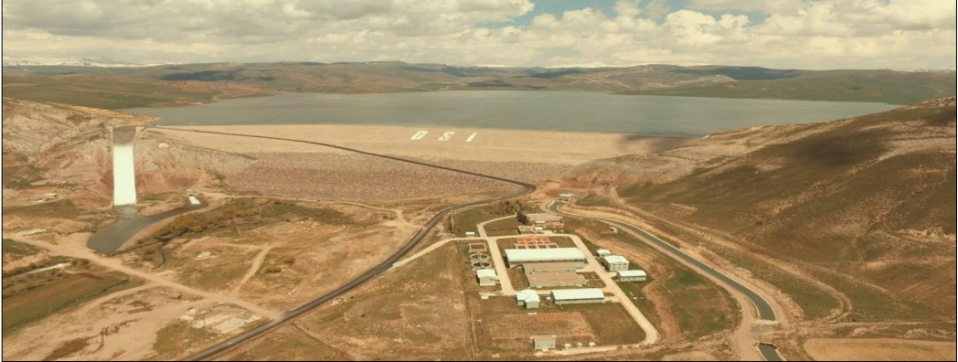
Fotoğraf 1. 3: Altınçayır Deresi üzerine inşa edilmiş Yazıcı Barajı'ndan bir görünüm
