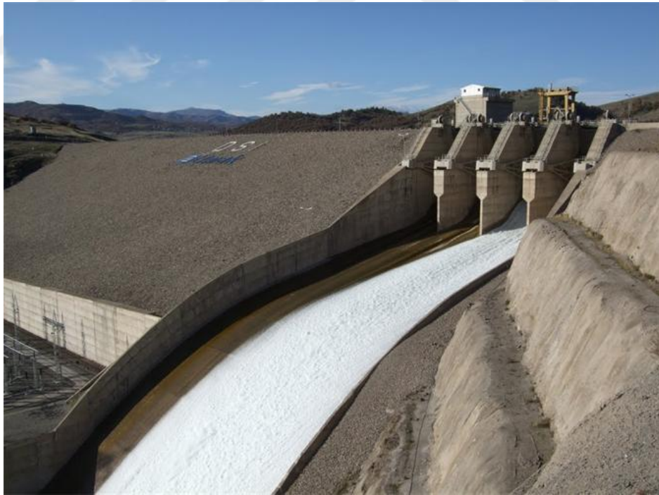
Şekil 2.2. Muş Alpaslan II Barajı dolusavak yapısı Üç önemli görevi vardır.
