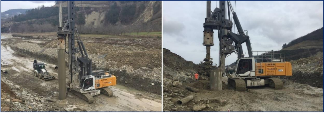
Şekil 3.10. Fore Kazık uygulaması ( https://www.temelttek.com.tr/en/dikmen-project-bored-pile-works/ )
