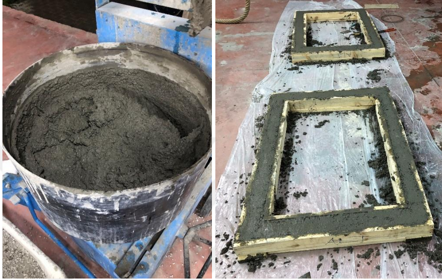
a) beton hazırlanması
