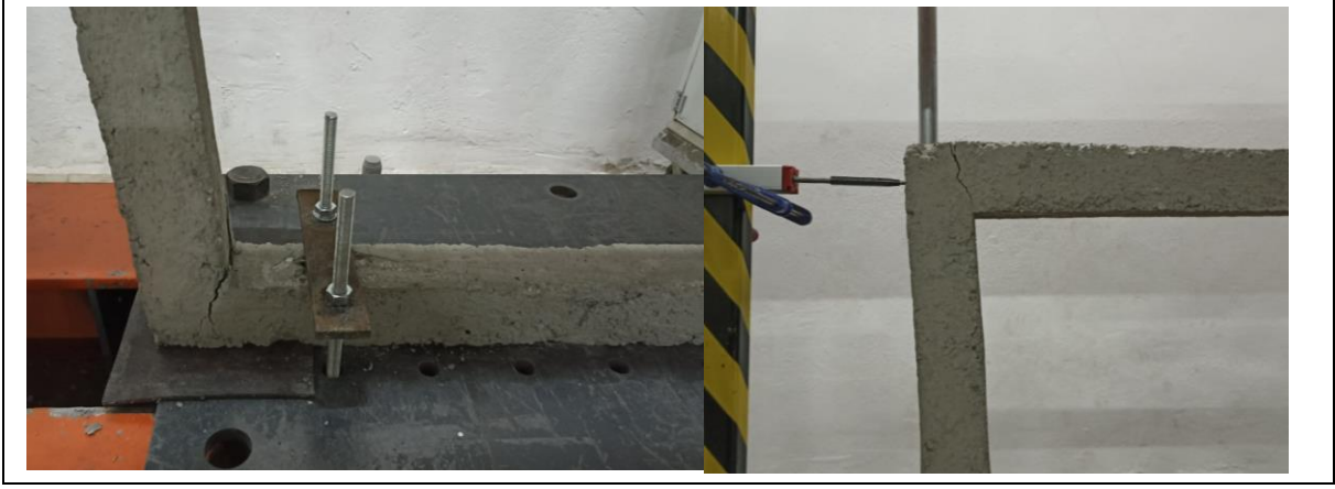
Şekil 4.68 Referans betonarme çerçeve statik itme analizi sonrasında zayıf düğüm noktalarındaki mafsallaşmalar
