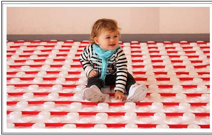
Şekil 4.3. Anaokullarında-kreşlerde yerden ısıtma örneği [26]
