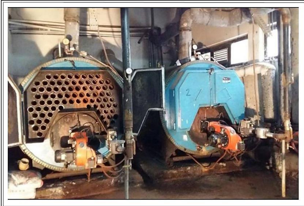
Şekil 4.2. Okullarda kullanılan sıvı yakıtlı kazanlar [24]
