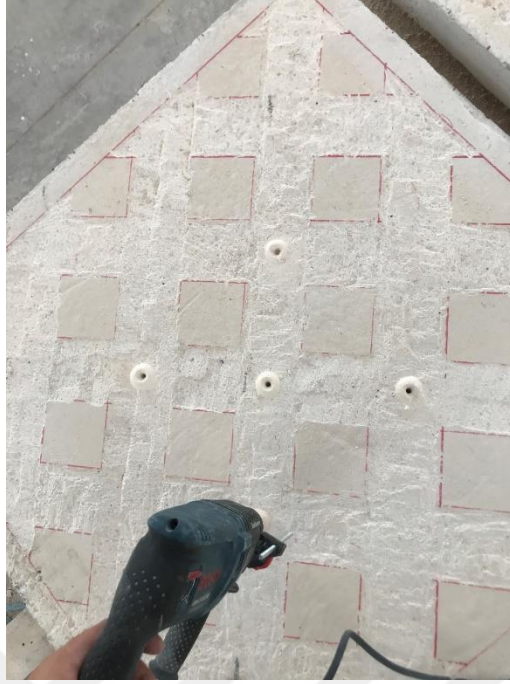
Şekil 4.13. Ankraj yapılacak plakların matkap ile delinmesi
