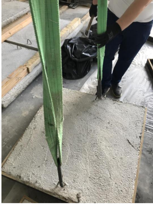
Şekil 4.7. Plakların vinç ile ters çevrilmesi
