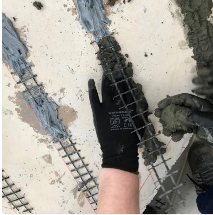
Şekil 4.14. Bazalt şeritlerin yapıştırılacağı bölgelere harç uygulaması
