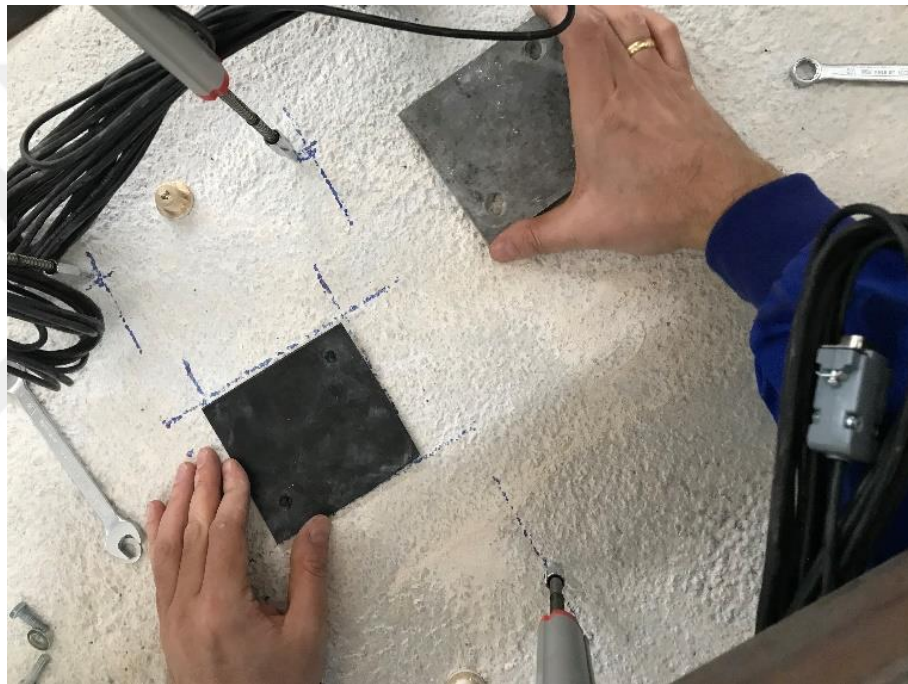
Şekil 3.6. Çelik plaka ve kauçuk montajı
