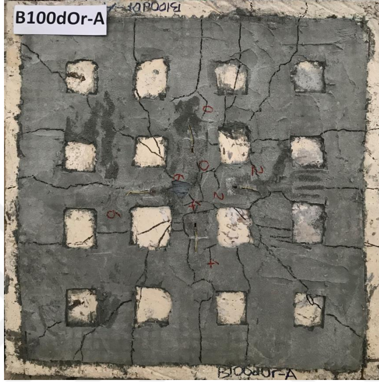
Şekil 5.65. B100dOr-A plağında meydana gelen çatlak dağılımı
