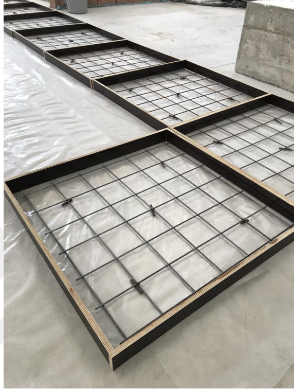
Şekil 4.3. Çelik donatıların yerleştirilmesi
