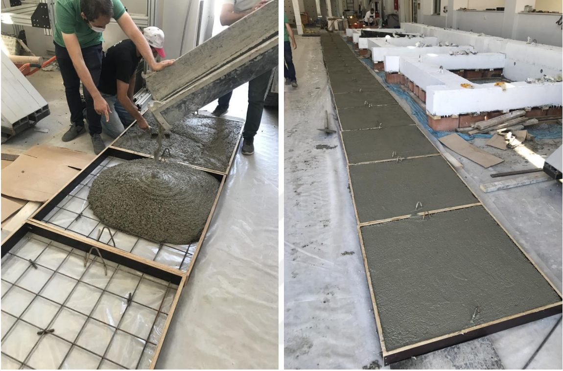
Şekil 4.4. 1000x1000x800 mm boyutlarındaki plakların beton döküm işlemi
