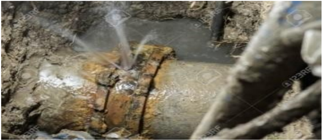
Şekil 5.1. Asbest boru örneği
