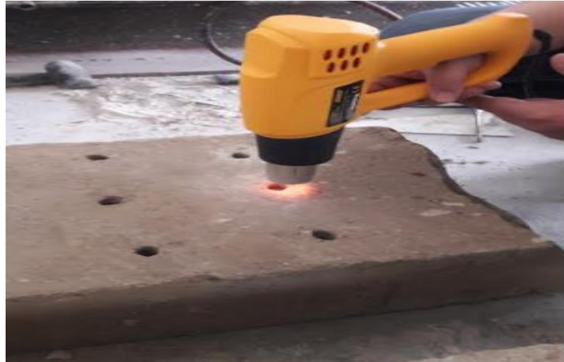
Şekil 5.11. Açılan deliklerin kurutulma işlemi.
