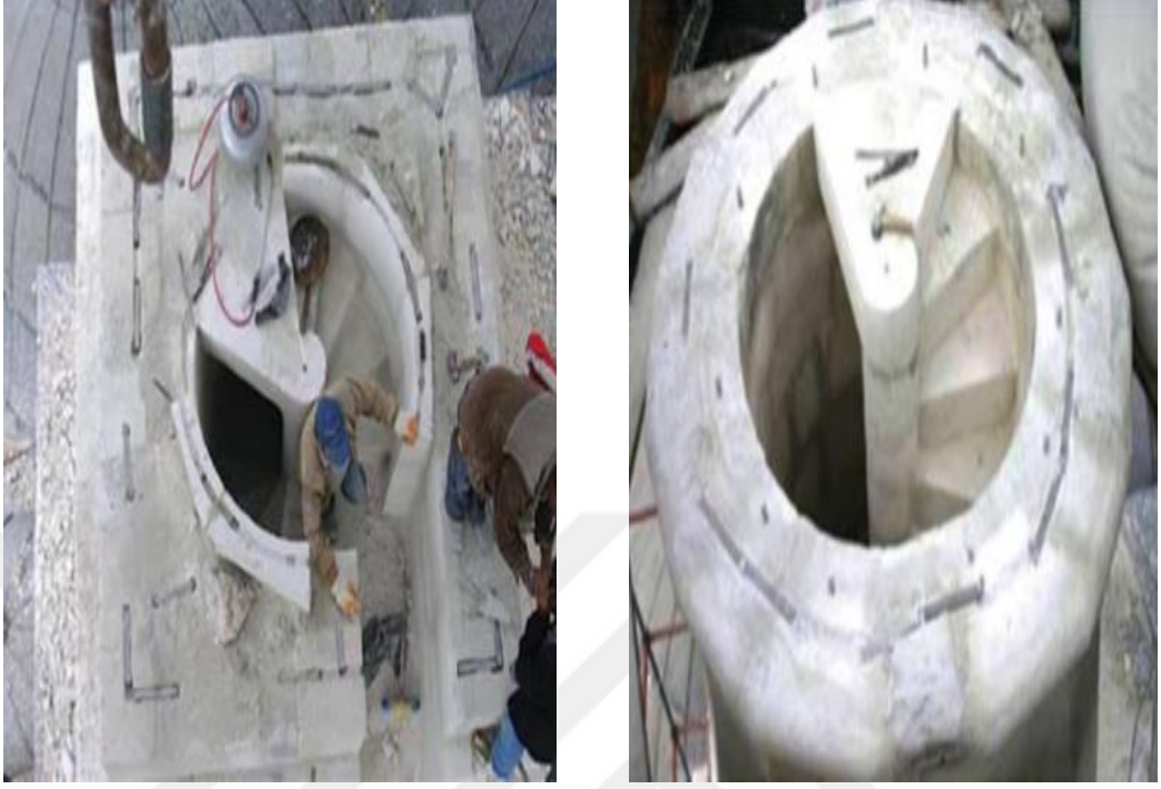
Şekil 4.10. Edirnekapı Mihrimah Sultan Cami minaresinde kullanılan kenet örnekleri (Kuşüzümü, 2010).
