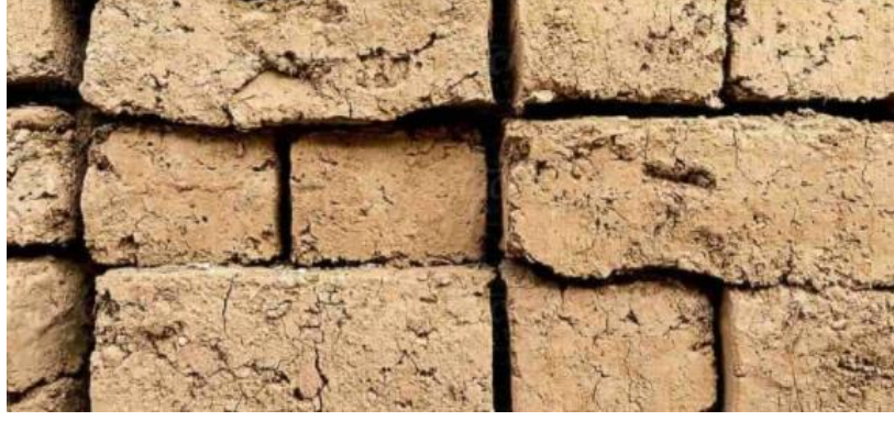
Şekil 3.11. Kerpiçten yapılmış bir duvar parçası (URL-16).
