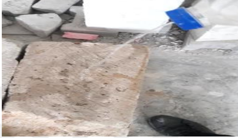
Şekil 5.10. Taşların ıslatılması işlemi.
