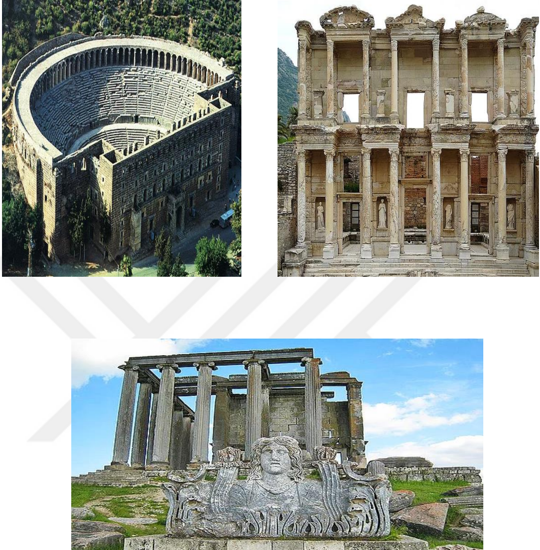
Şekil 1.3. Yığma yapı tekniği ile yapılmış tarihi yapılar (URL-3).
