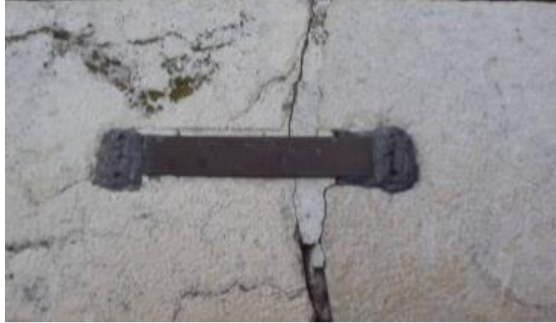
Şekil 4.9. Kırık taşların onarımında kullanılan kenet uygulaması (Koçak, 2013).
