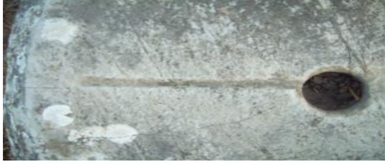
Şekil 4.12. Yatay kurşun akıtma kanalı (Demirtaş, 2006).
