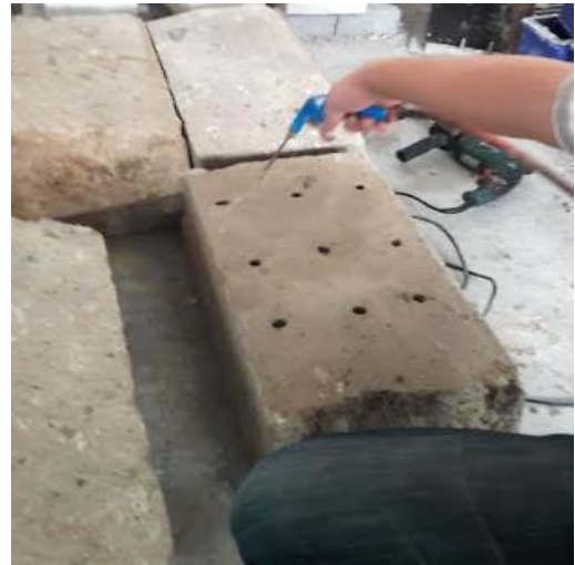
Şekil 5.13. Kompresör yardımıyla delikteki tozları temizleme işlemi.
