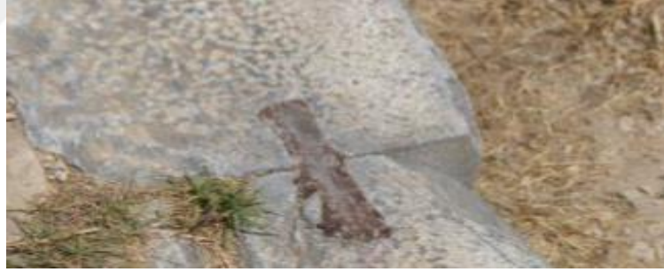
Şekil 4.3. Knidos Yuvarlak Tapınağı'ndaki kırlangıç kuyruğu kenet (URL-21).
