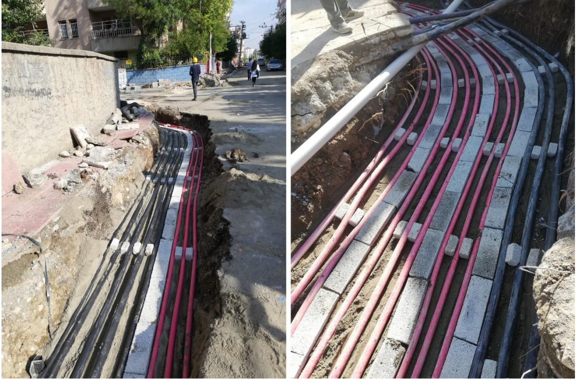
Şekil 4.5. Şehir içi Yeraltı Elektrik Kablo Montaj Uygulamaları
