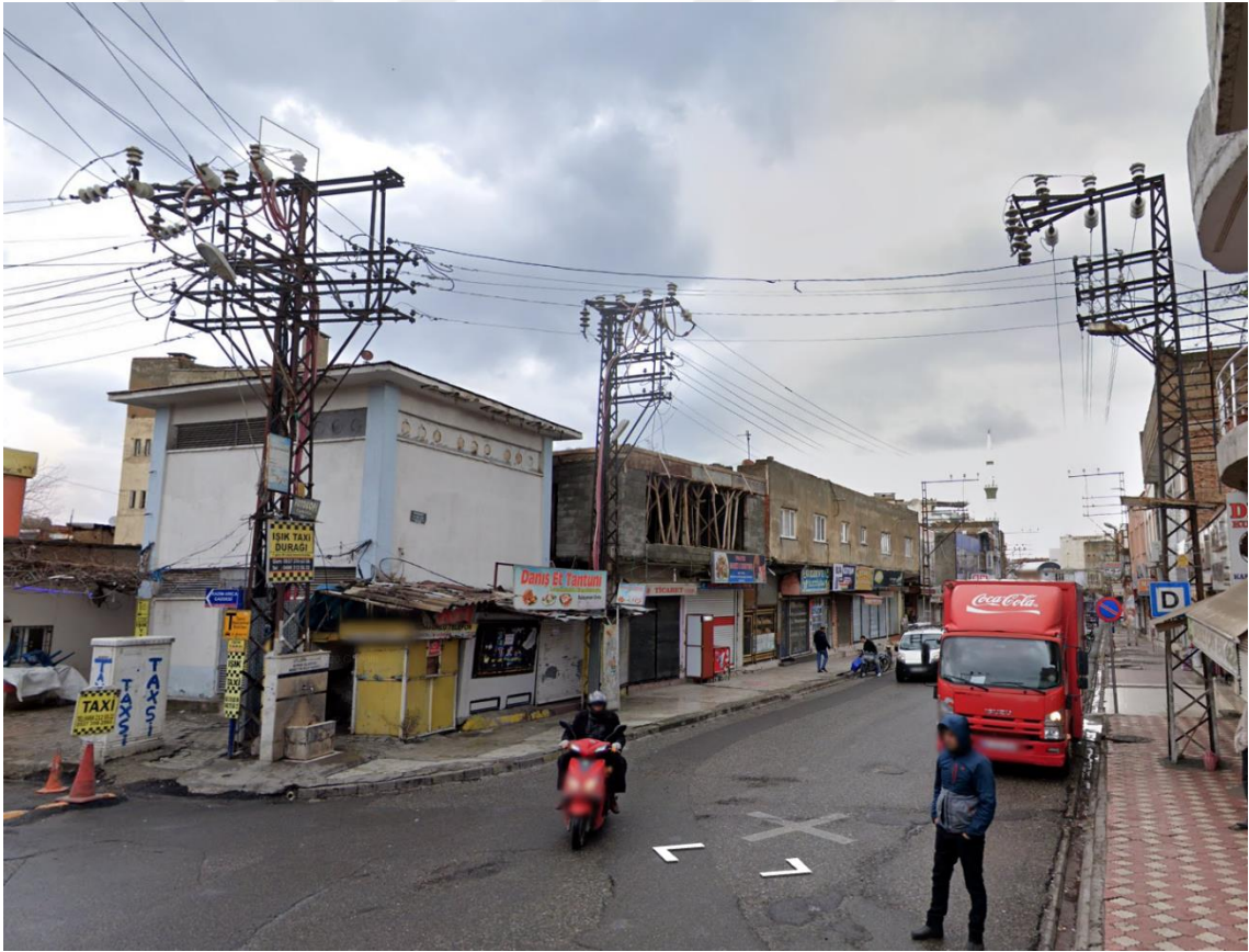
Şekil 4.4. Şehir içi Havai Hatlı Elektrik Dağıtım Şebekesi
