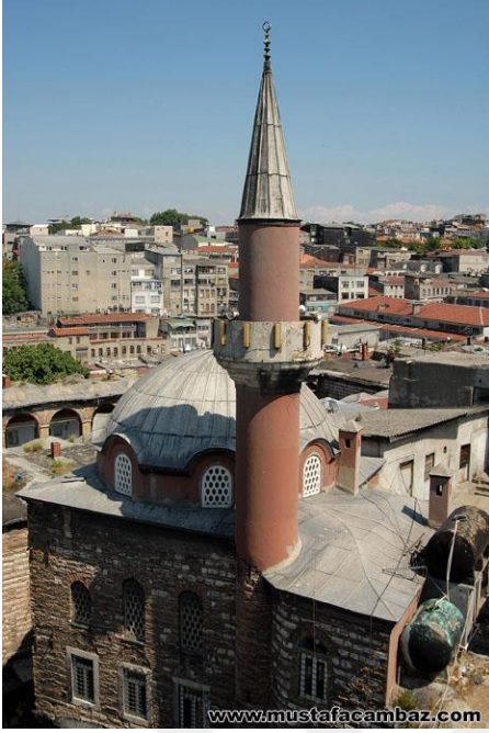
Şekil 5.21. Merkezi plana sahip tek minareli, tuğla ve taş ile örülmüş Çakmakçılar Cami Fotoğraf: Mustafa Cambaz 22.01.2010
