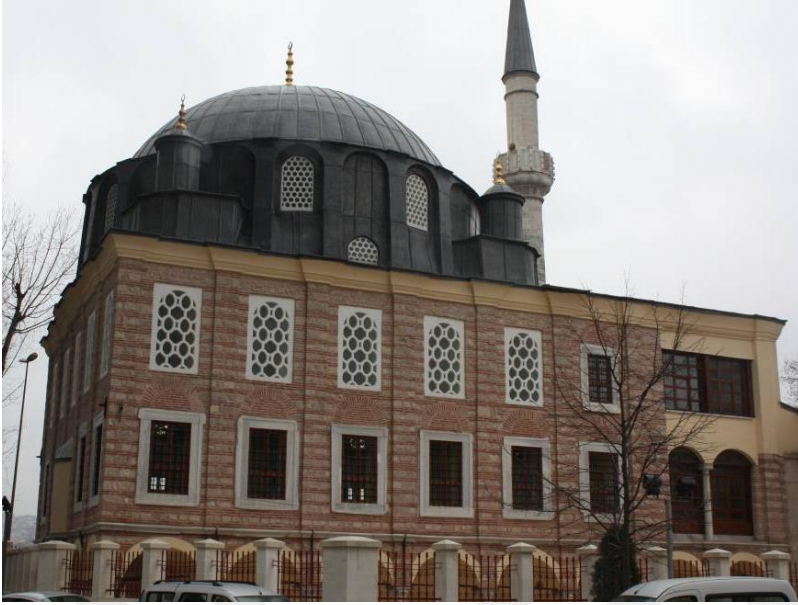
Şekil 5.31. Yüksek bir kasmağa oturan, bağdadi sıvalı ve dışarıdan kurşun kaplamalı kubbe https://kadiogluinsaat.net/portfolio-item/humbarhane-camii-2/ erişim tarihi: 03.11.2021
