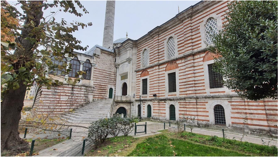
Şekil 5.18. Almalıık duvar sistemine sahip Laleli Cami
