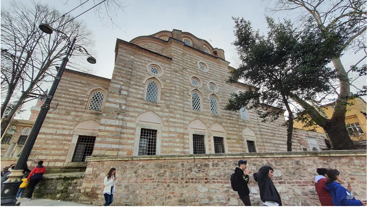
Şekil 5.20. Almaşık duvar sistemine sahip Zeynep Sultan Cami, 2022
