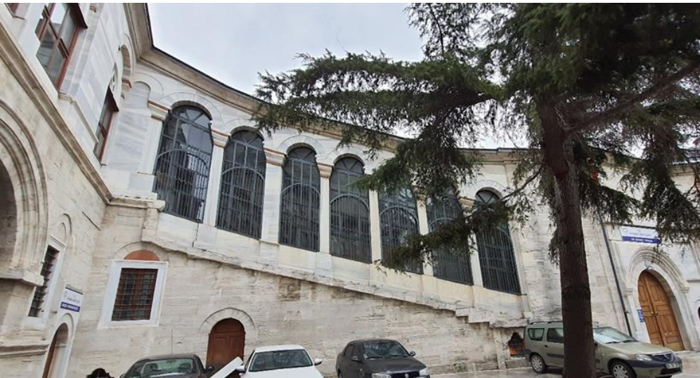
Şekil 5.3. Hünkar mahfiline çıkan rampa
