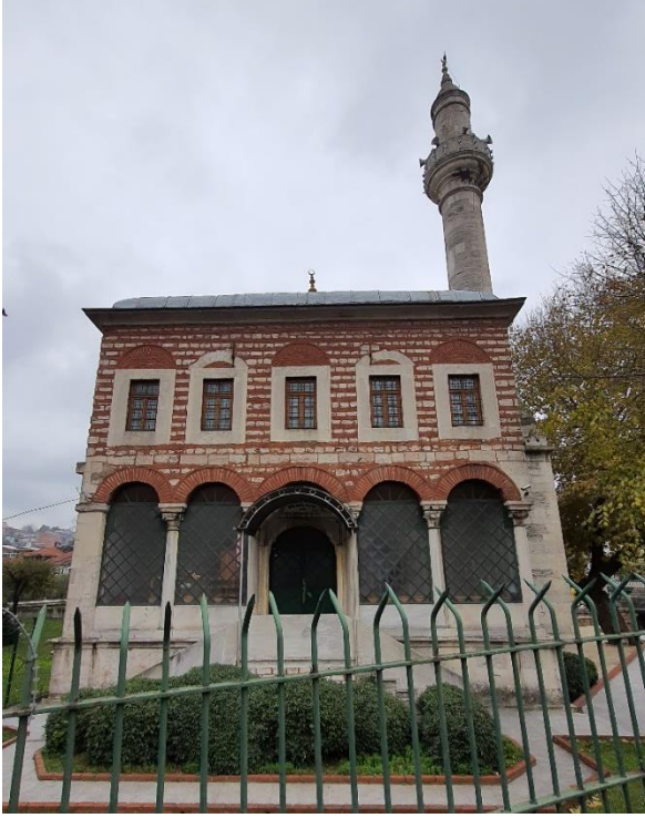
Şekil 5.29. Almaşık duvar sistemine sahip Şebsefa Hatun Cami
