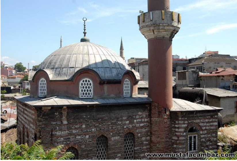
Şekil 5.22. Almasıık duvar sistemine sahip Çakmakçılar Cami, Mustafa Cambaz, 2010 https://www.mustafacambaz.com/details.php?image_id=21516 erişim tarihi: 22.01.2022
