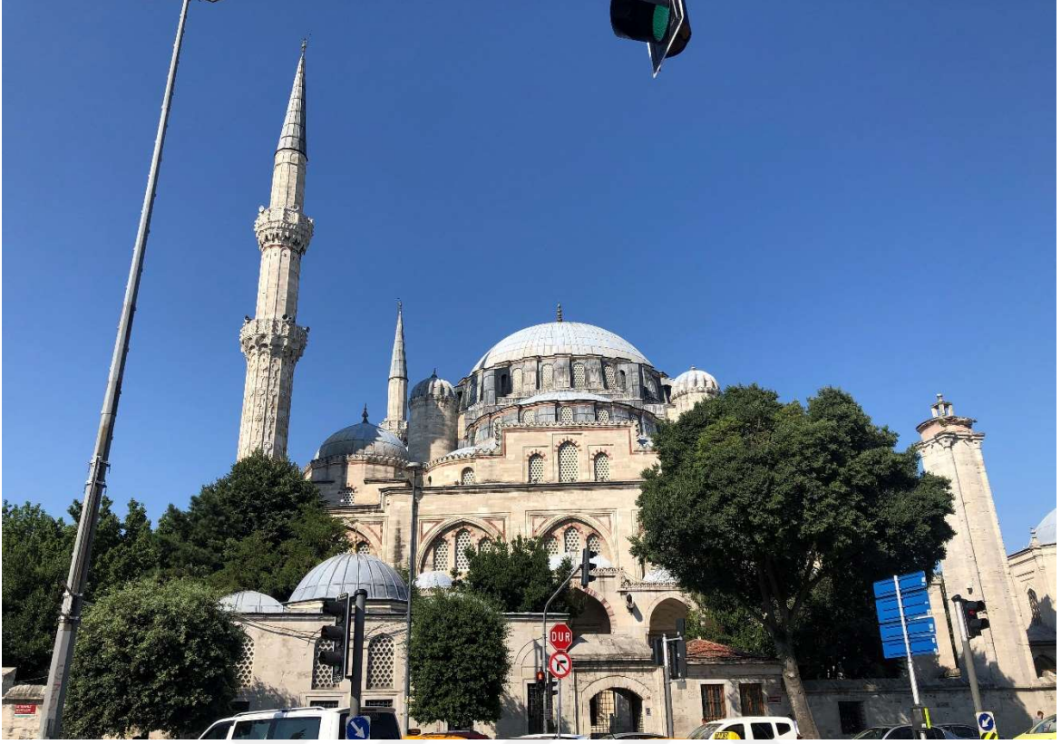
Şekil 4.9: Şehzade Camii cephe görüntüsü (Furkan Topal fotoğraf arşivinden)
