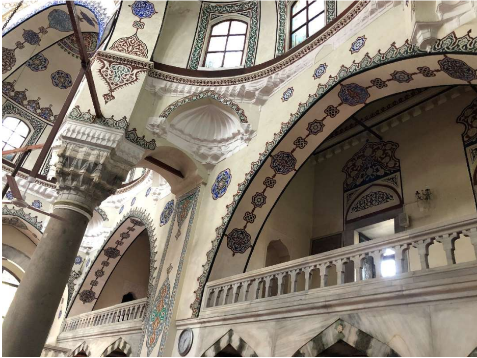
Şekil 4.39: Gazi Ahmet Paşa Camii mahfil ve yan payanda görüntüsü (Furkan Topal fotoğraf arşivinden)
