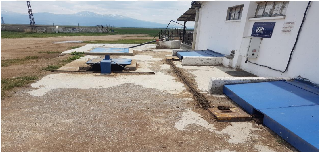
Şekil 4.22. Gübrenin sıyrıcılar aracılığıyla ön depoya oradan gübre çukuruna taşındığı bir işletme (Sinanpaşa, 2017)
