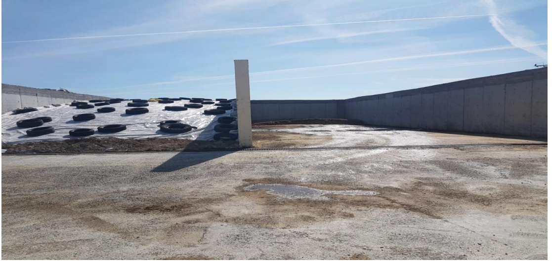
Şekil 4.18. Çalışma alanında tekniğine uygun olarak inşa edilmiş bir silaj deposu (Bolvadin, 2017)
