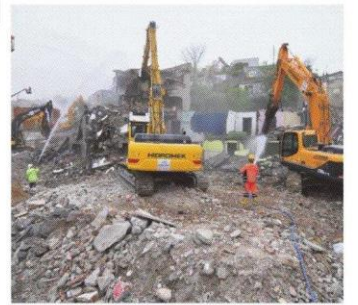
Sarıgöl'de seçilen 393 hektarlık alandaki çalışmalarda çürük yapılar yıkılıyor.
