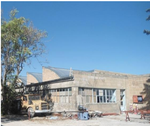
F 11: Kayseri Dokuma Fabrikası dokuma binası tadilat halindeyken (20 Ekim 2016)
