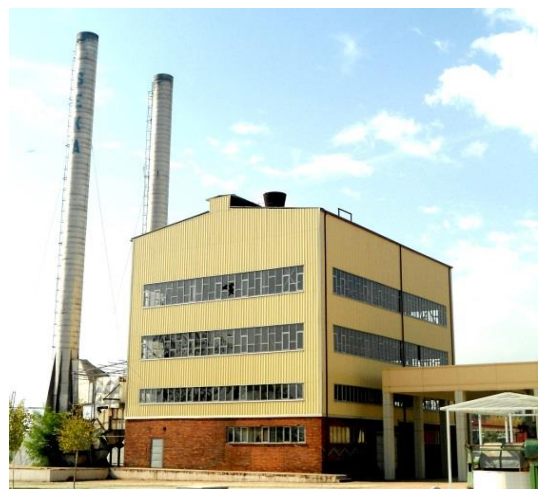
F 76: İzmit Kâğıt Fabrikası Enerji santrali (12 Ekim 2016)
