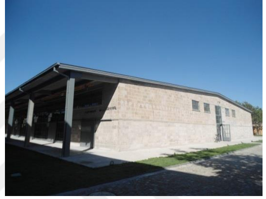
F 10: Abdullah Gül Üniversitesi Mimarlık Fakültesi atölye binası (Eski dönem dokuma fabrikası büyük ambar binası) 20 Ekim 2016
