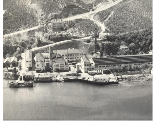
F 53: Gemlik Sunğıpek Fabrikası'nın üstten görünüşü
