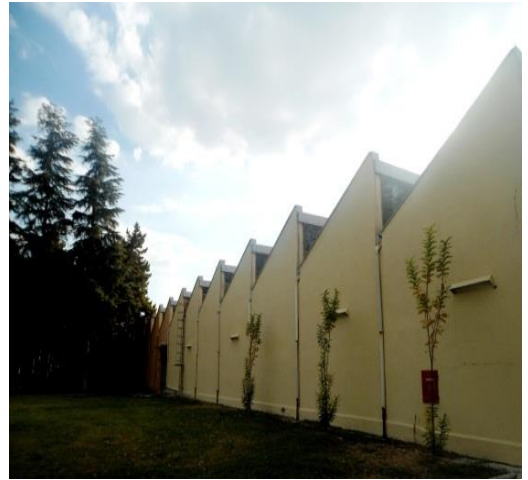
F 24: Ereğli Bez Fabrikası dokuma binası (24 Ekim 2016)
