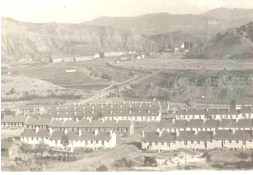
F 97: Karabük Demir ve Çelik Fabrikaları işçi lojmanlarının toplu bir görünüşü
