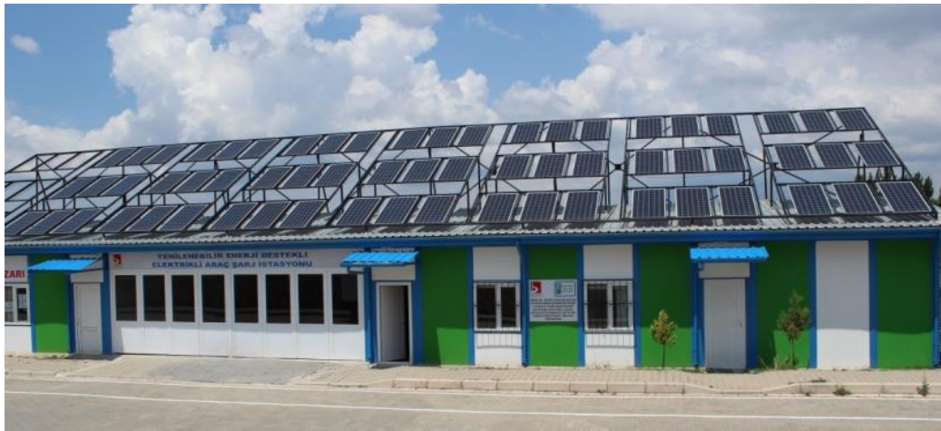
Şekil 5.2. FV panellerin montajı.
