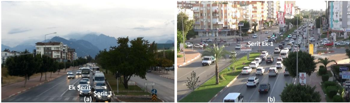
Şekil 1.5. a) Sinyalize bir kavşakta meydana gelen ek dönüş cebi oluşumu ve b) düz gidiş şeritlerin sayısında meydana gelen azalma.
