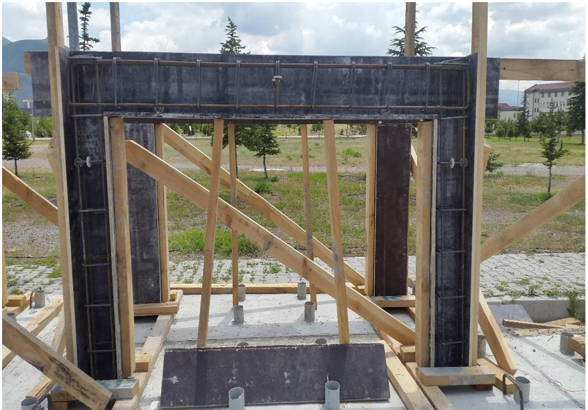
Şekil 3.5. Donatıları tamamlanmış çerçeve
