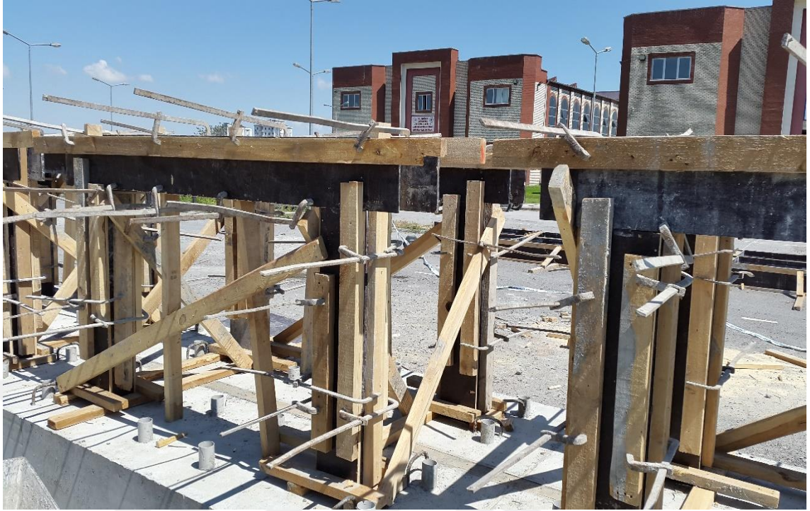
Şekil 3.6. Hazırlanan çerçeve kalıpları
