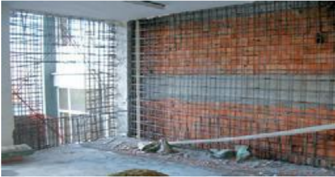
Şekil 2.3. Dolgu Duvarların Hasır Çelik Donatılı Özel Sıva ile Güçlendirilmesi
