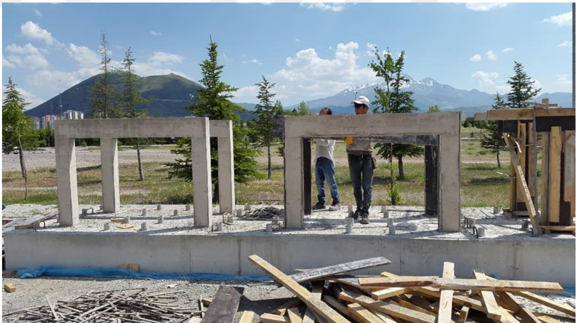
Şekil 3. 10: Çerçevesinin kalıplarının sökülüş şekli
