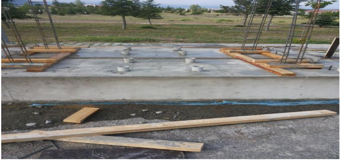
Şekil 3. 2: Kalıpları sökülmüş temel
