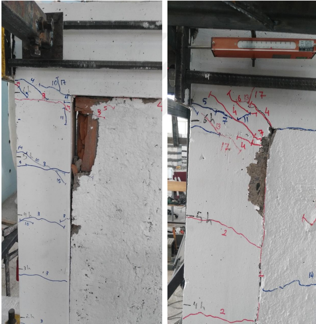
Şekil 4.11. 17. döngü sonunda oluşan çatlaklar ve dökülmeler
