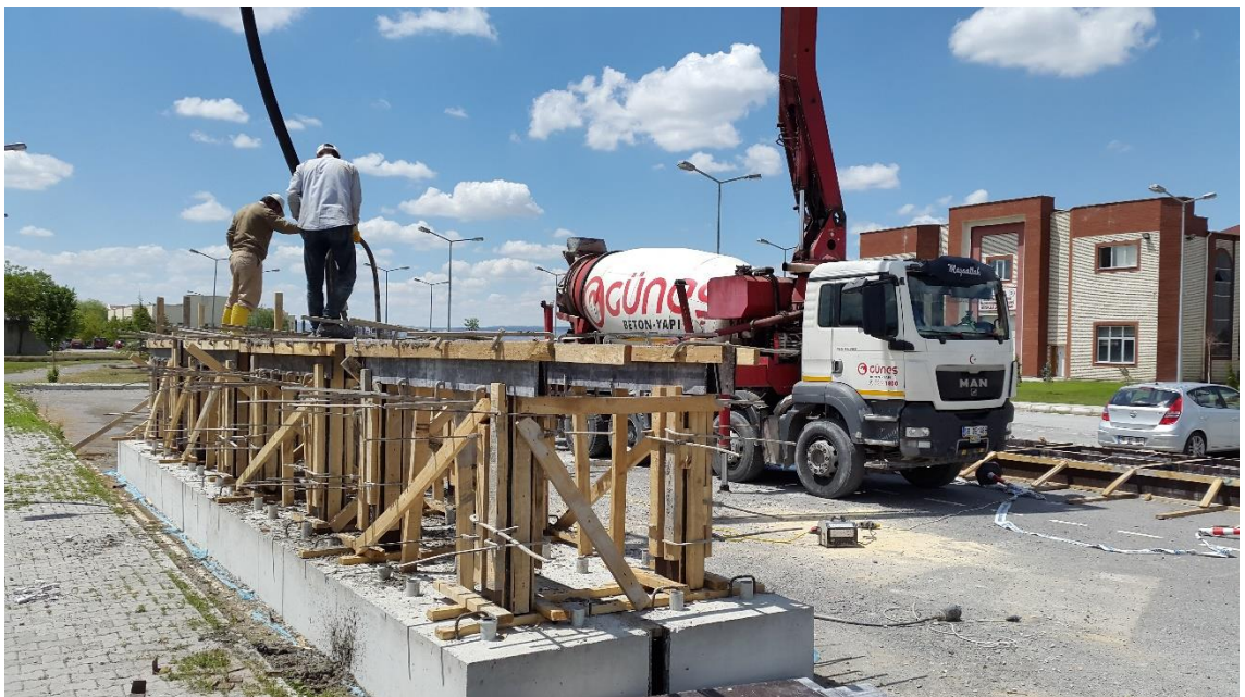
Şekil 3.7. Çerçeve betonlarının dökümü
