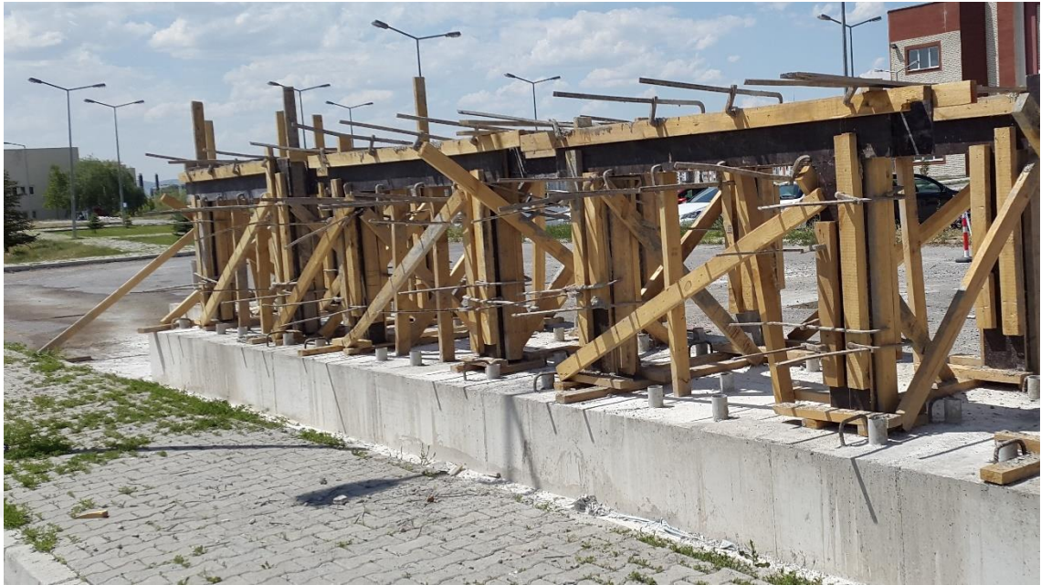
Şekil 3.8. Beton dökümü tamamlanmış çerçeveler
