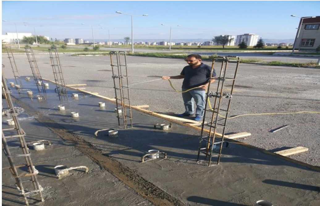
Şekil 3.3. Temel betonu kuru
