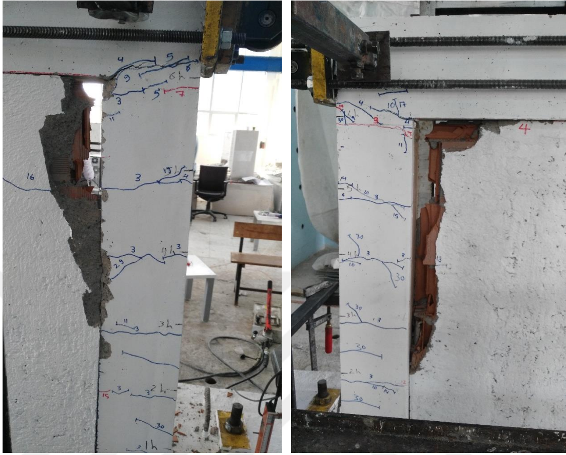
Şekil 4.12. 30. döngü sonunda oluşan çatlaklar ve dökülmeler
