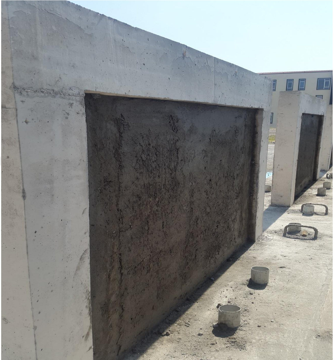
Şekil 3.13. Bölme duvarlara sıva yapılması iç yüz
