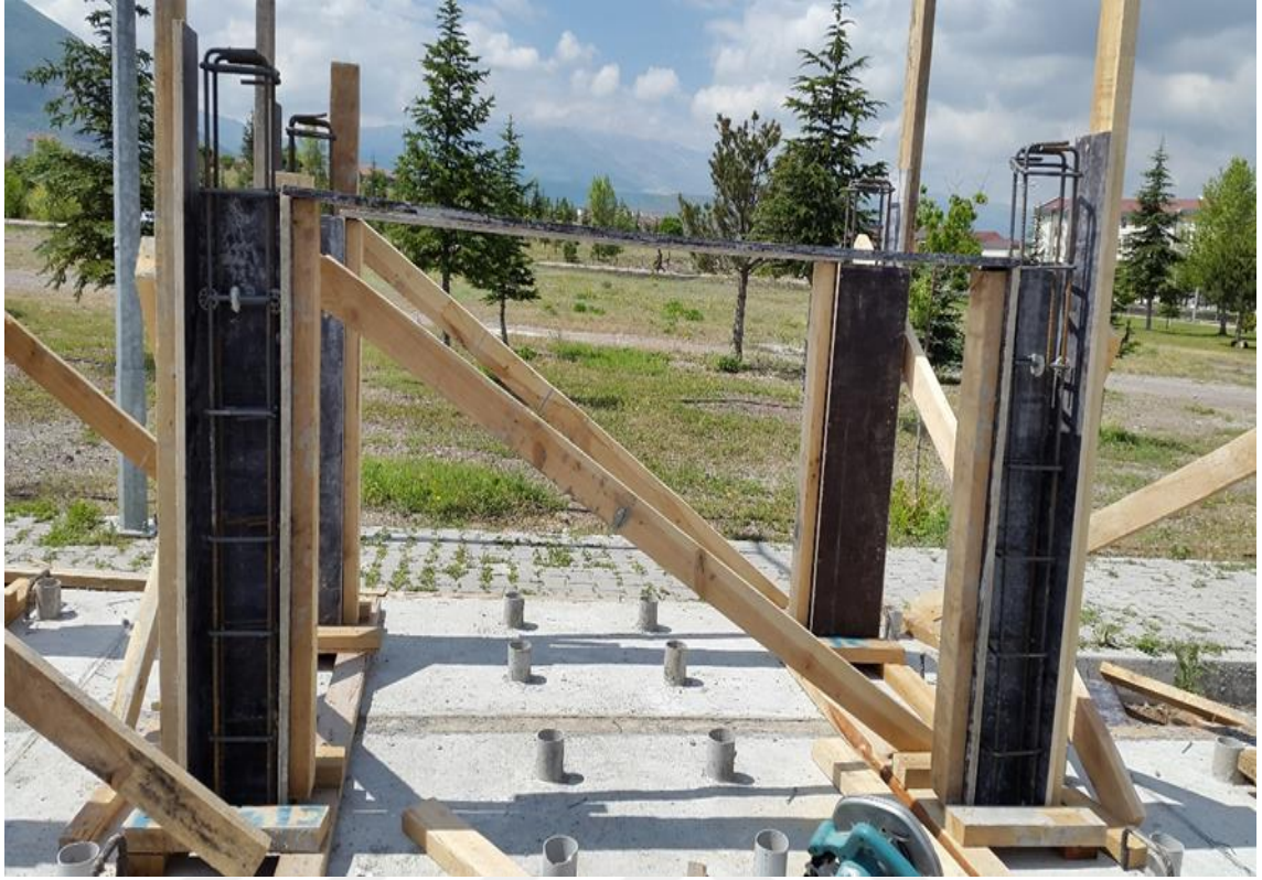
Şekil 3. 4: Çerçeve kalıplarının ve donatılarının yapımı
