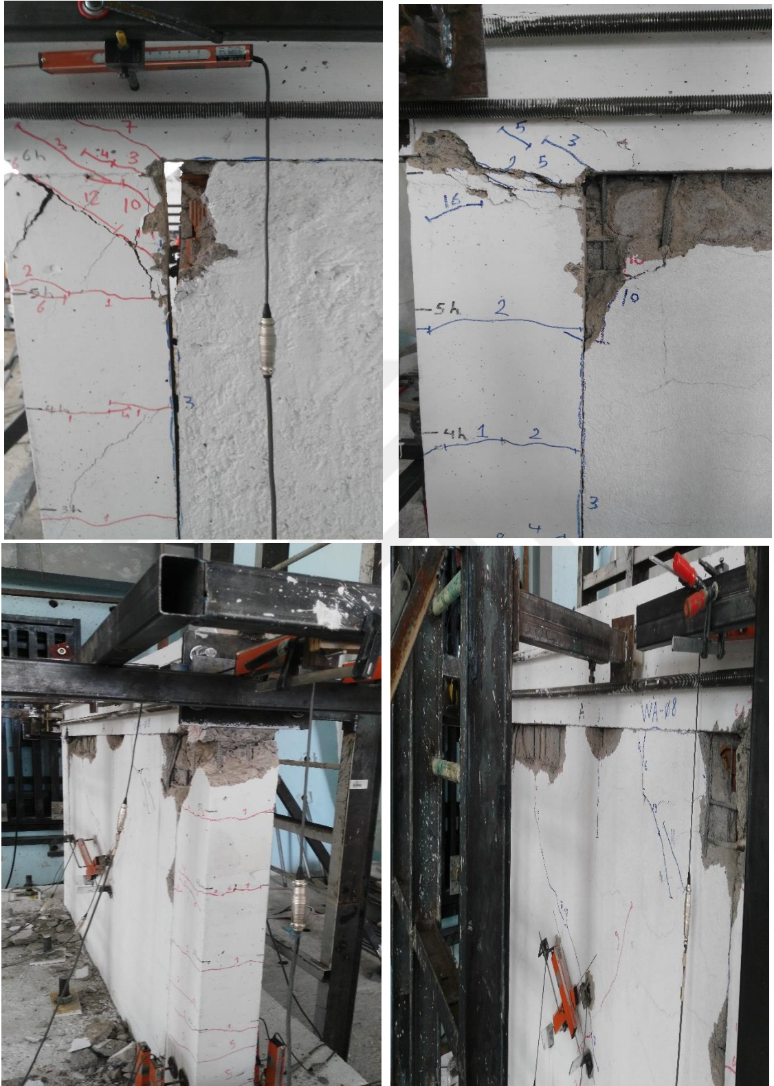
Şekil 4.18. 24. döngü sonunda çatlak ve dökülme durumu.
