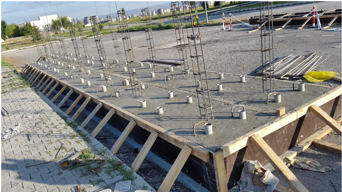
Şekil 3.1. Temel betonu
