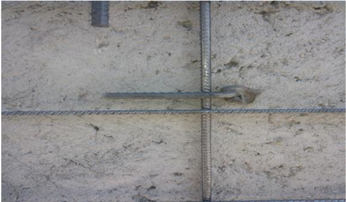
Şekil 3. 22: Duvar düzlemine dik ankraj yapımı
