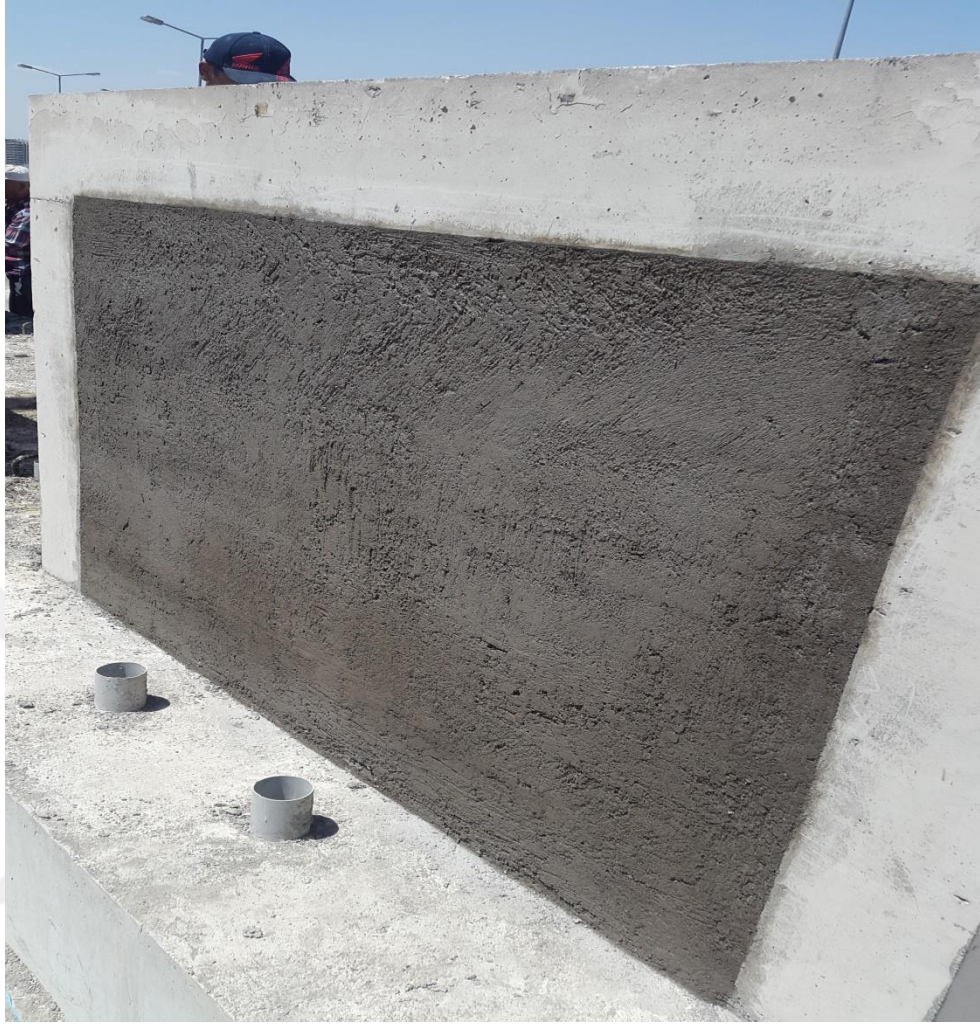
Şekil 3.14. Bölme duvarlara sıva yapılması dış yüz
