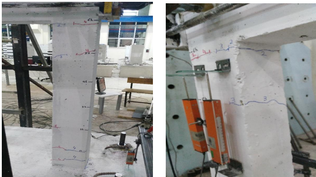
Şekil 4.2. 4. döngü sonunda çatlak durumu
