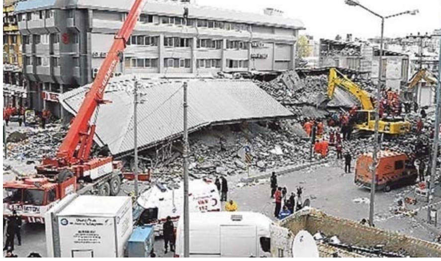
Şekil 4.2. Bayram otelin güney cephesinden yıkılma durumu.
