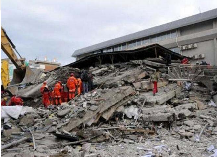
Şekil 4.3. Bayram otelin doğu cephesinden yıkılma durumu.
