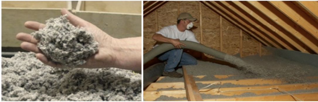
Şekil 3.19 : Gevşek dolgu selüloz yalıtım ve uygulama örneği [52].
