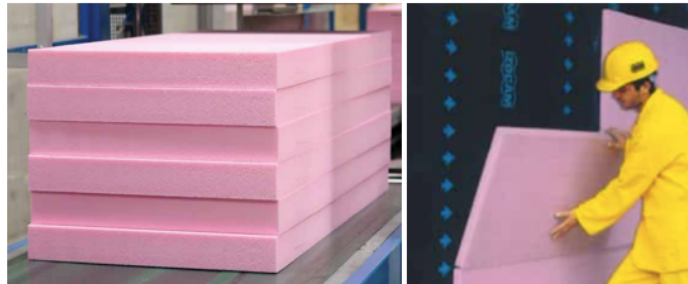
Şekil 3.22 : XPS malzeme ve uygulama örneği [45].
