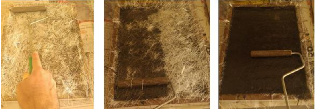
Şekil 3.34. Liflerin el yatırması yöntemiyle reçine içerisine emdirilmesi.
