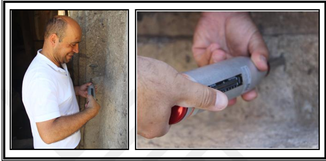
Şekil 3.2 Yapı ön duvarında Schimdt çekici sertliği ölçümü
