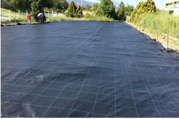
Şekil 3.4 Malç serme ve dikim çukurları yerlerinin belirlenmesi
