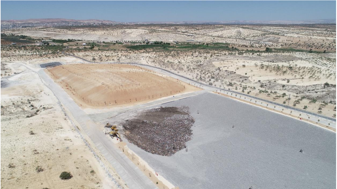
Şekil 4.3: Nizip Katı Atık Düzenli Depolama Alanı (GBB, 2018)
