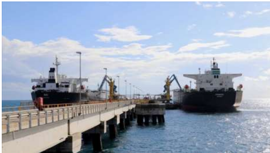
Şekil 1. Eklemlili kollu boşaltım sistemi ile petrolün pompalanması (Bozkurt, 2021).
